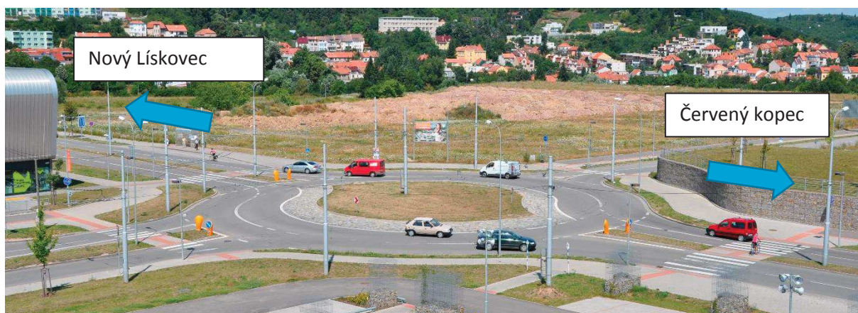
Obr. 100 Pohled na TOK v Brně - Bohunicích
