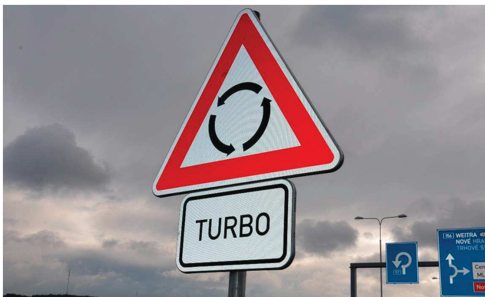
Obr. 70 Nelogicky použitá dopravní značka na TOK v Českých Budějovicích – Nové Hodějovice, kdy použitá dodatková tabulka může evokovat zrychlování vozidel před TOK.
