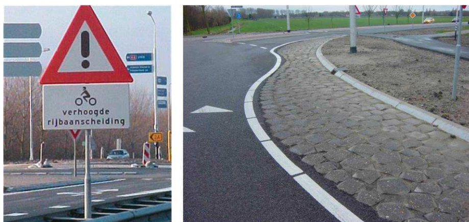
Obr. 22 Výstražná značka „zvýšené oddělení jízdních pruhů“ pro motocyklisty a srpovitá krajnice určená pro pojezd kloubovými vozidly (převzato z [2])
