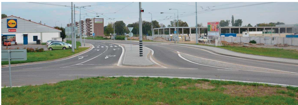
Obr. 37. Brno – křižovatka ulic Olomoucká x Řípská, fyzické oddělení jízdnic pruhů na výjezdu.
