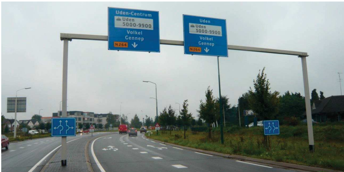
Obr. 10 Svislé a vodorovné dopravní značka před okružní křižovatkou se spirálovitým uspořádáním (TOK – Holandsko – město Uden)
