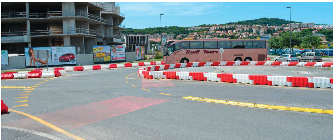
Obr. 45 Mobilní, provizorní TOK v Treste
