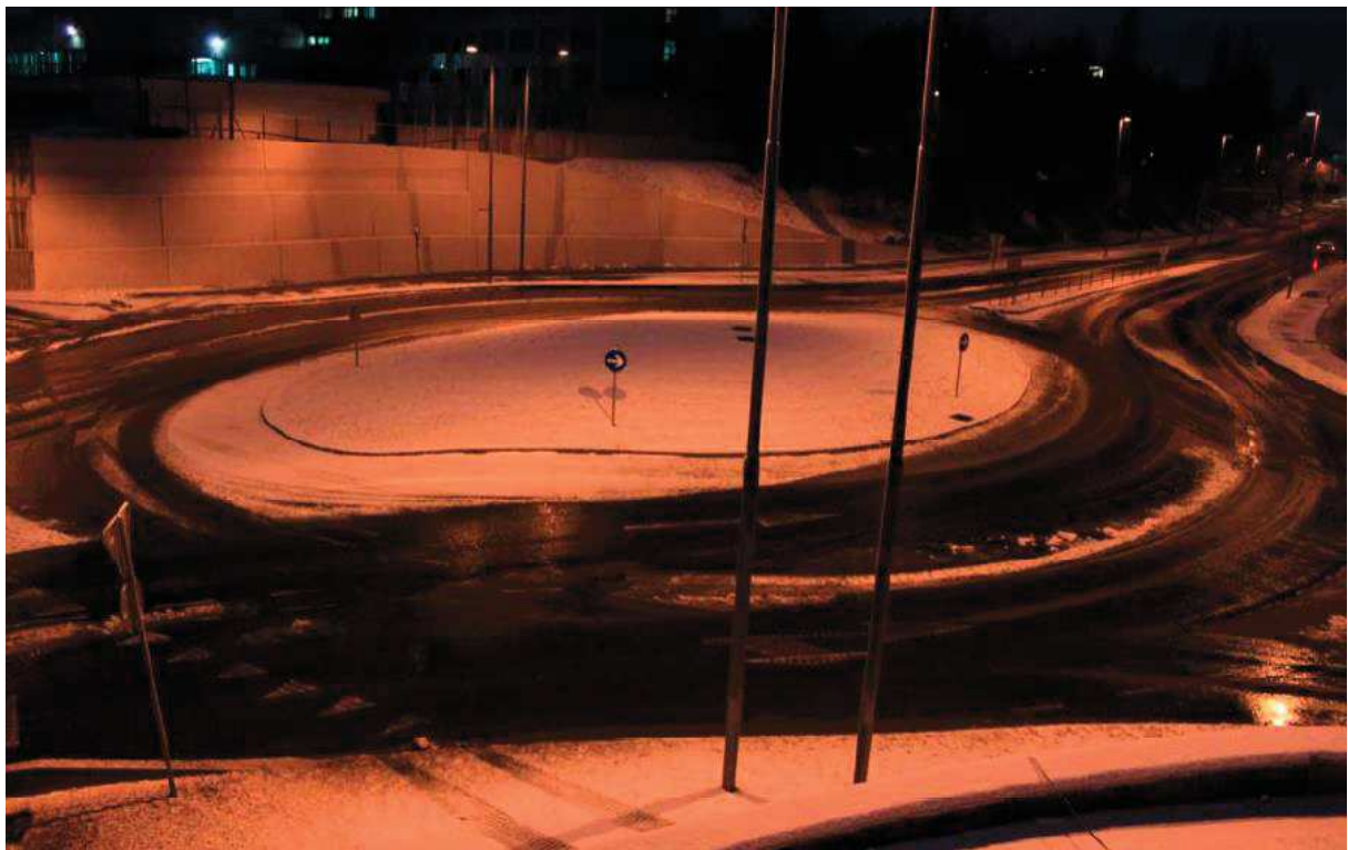
Obr. 51. Slovinsko – Maribor – turbo-okružní křižovatka s fyzickým oddělením jízdních pruhů v zimním období po provedení zimní údržby (Převzato z: TOLAZZI, Tomaž; RENČELJ Marko a TURNŠEK Sašo; TURBO ROUNDABOUTS – SLOVENIAN EXPERIENCES).
