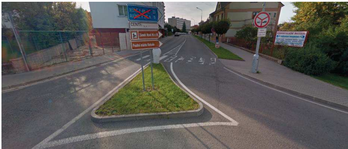
Obr. 121 Příklad osazování směrových tabulí v čele dělicího ostrůvku – Nové Město nad Metují (zdroj https://www.google.cz/maps )
