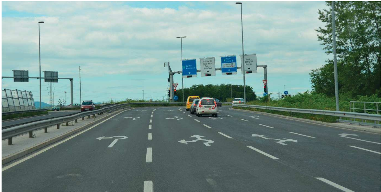
Obr. 46. Slovinsko – Ljubljana – světelně řízená turbo-okružní křižovatka.
