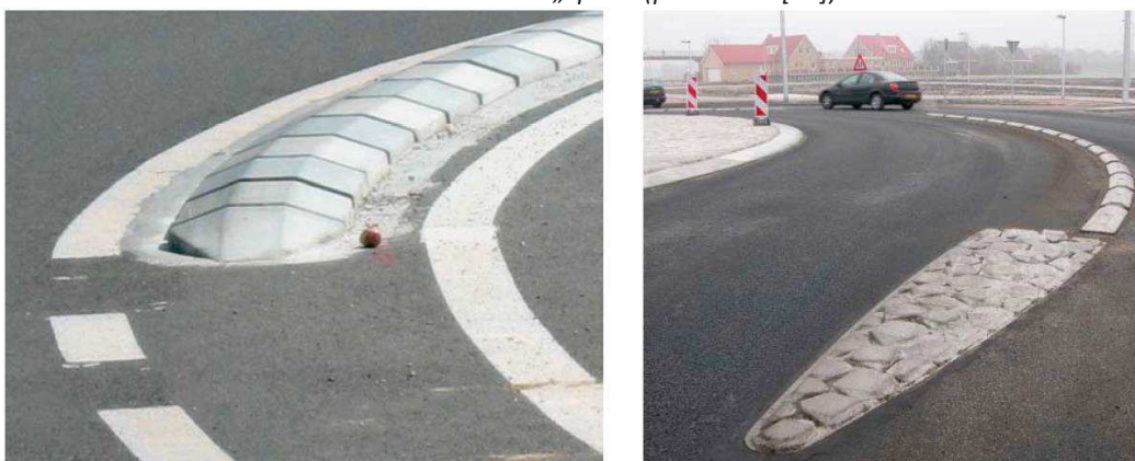
Obr. 36 Možná provedení „špice“ (převzato z [19])
