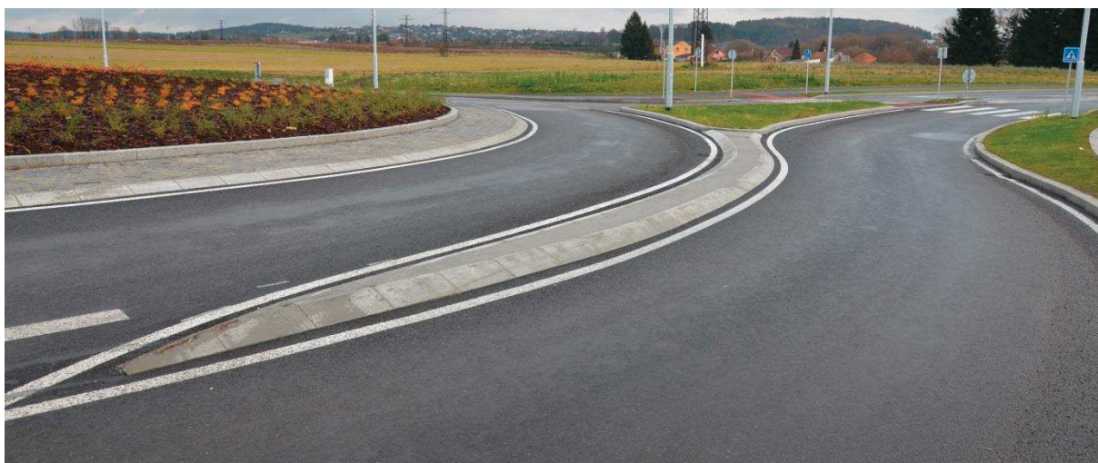
Obr. 39. České Budějovice – detail fyzického oddělení jízdnic pruhů na okružním pásu.
