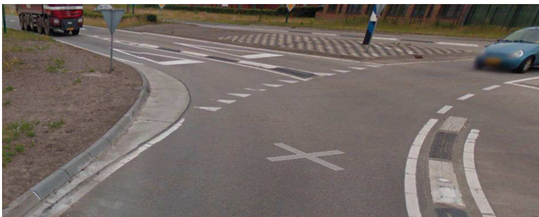
Obr. 67 Pohled na úpravu vjezdu do TOK v Nizozemí - Uden (zdroj google)
