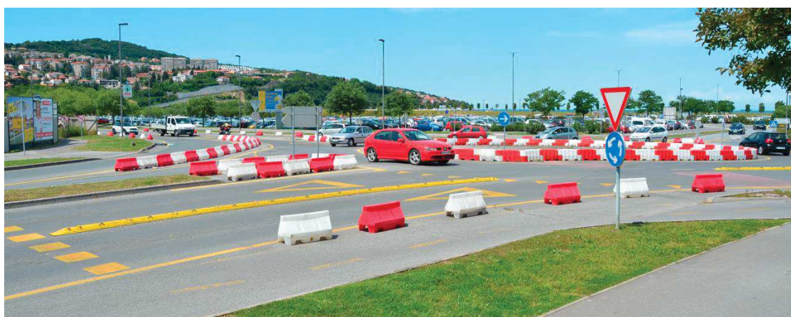
Obr. 46 Mobilní, provizorní TOK v Treste
