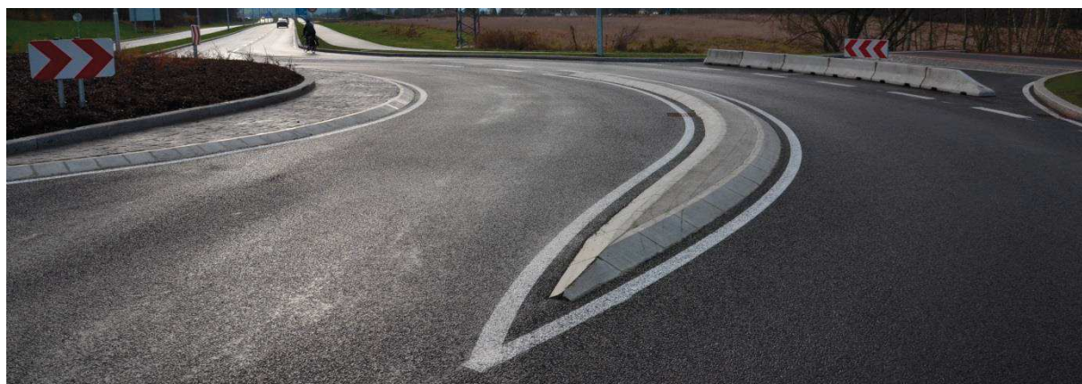
Obr. 68 Pohled způsob fyzického oddělení na TOK v Českých Budějovicích – Nové Hodějovice
