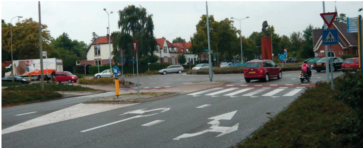
Obr. 96 Pěchod pro chodce a přejezd pro cyklisty na vjezdu do okružní křižovatky ve městě Harderwijk
