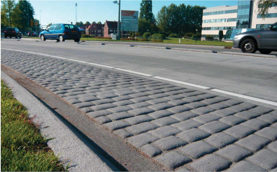
Obr. 25 Detail provedení „přídlažby“ na TOK Nizozemí. Vzhledem k nedostatku přírodního kamene v Nizozemí, jsou prstence na OK betonové (zdroj: Ing. Michal Kosňovský, Ph.D.)
