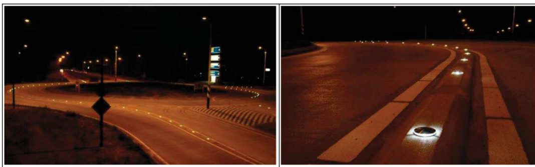
Obr. 21 Příklad osvětlení za pomoci LED diod pro zlepšení viditelnosti fyzického oddělení jízdních pruhů (převzato z [47])
