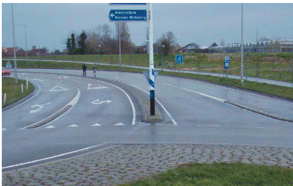
Obr. 29 Kapkový dělicí ostrůvek v uspořádání bez přítomnosti nemotorizovaných účastníků silničního provozu (převzato z [18])
