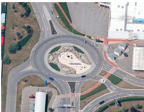
Obr. 73 TOK v Brně – Modřicích, OC Olympia
