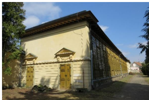
Obr. 58: Palmový skleník v horní části zámeckého parku (Zdroj vlastní, 25. 3. 2018).
