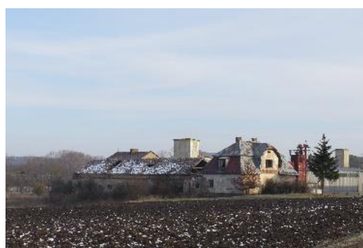
Obr. 110: Budovy hospodářského dvora Puličky (Zdroj vlastní, 19. 2. 2018).
