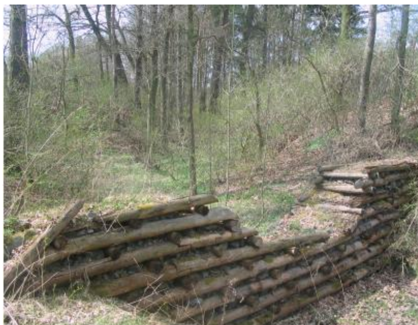
Obr. 15 – Přehrážka z dřeva a kameniva ve strži u obce Spáňov [14]
