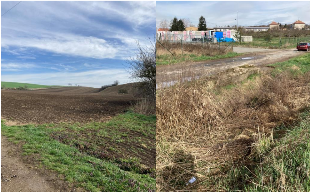
Obr. 22 – KB2 – pohled na sběrné povodí (vlevo), uzávěrový profil – neudržovaný propustek (vpravo)
