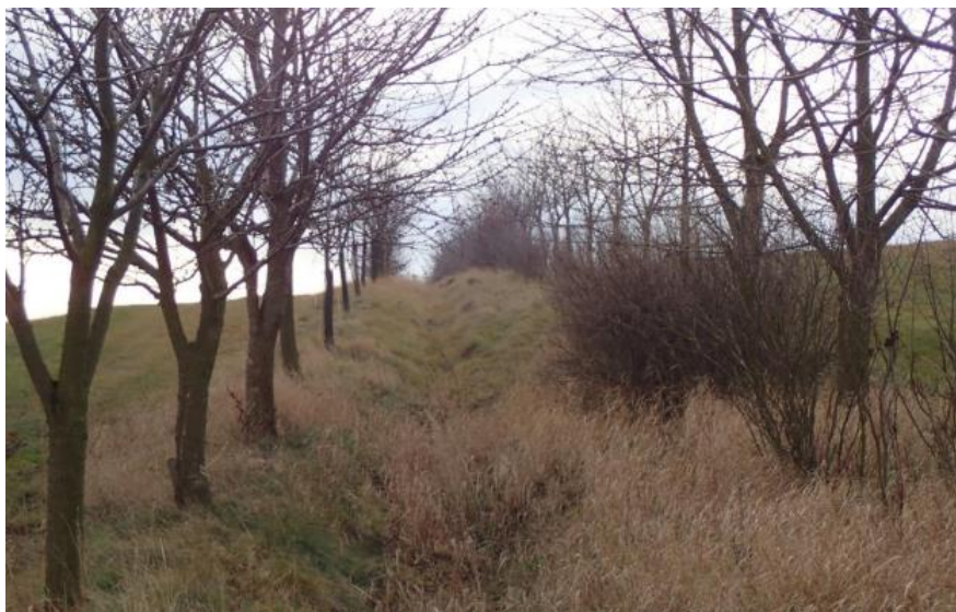
Obr. 13 - Záchytný zatravněný příkop v k.ú. Brodek u Konice [26]
