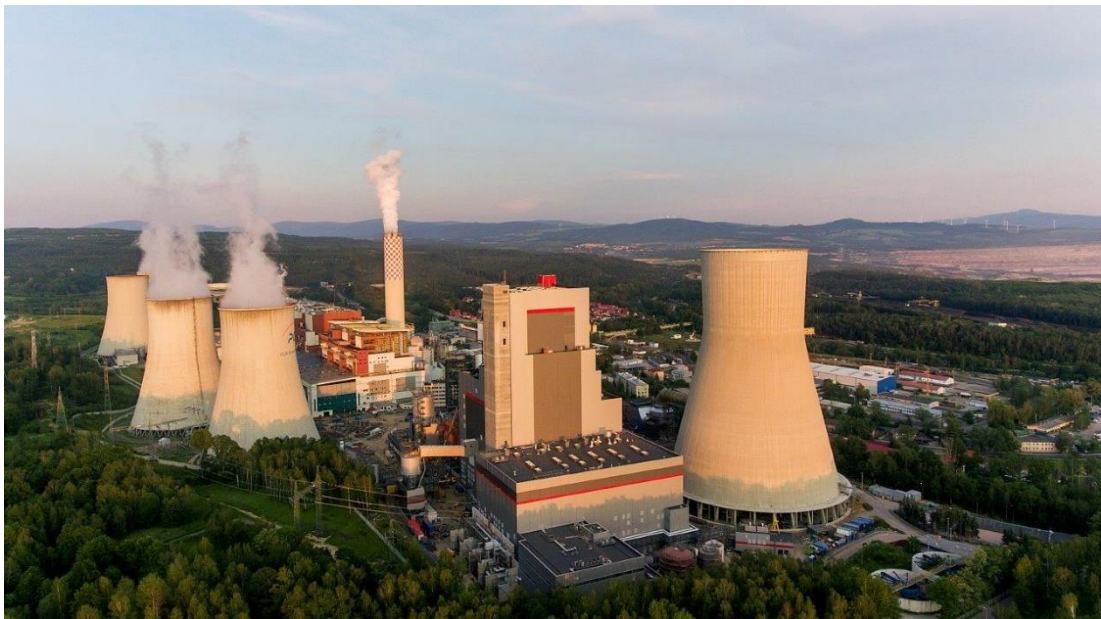
Příloha 4: Pohled na elektrárnu Turów. V předu je nová chladicí věž a nový blok č. 7, za ním pak starší bloky a objekty. Zalesněný svah za elektrárnou je zrekultivovaná vnější výsypka, vpravo od ní je vidět část jámy povrchového dolu (PGE, 2021a).
