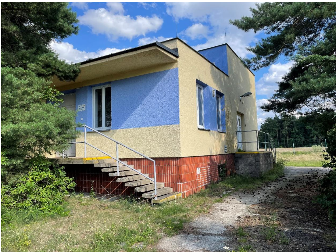
Příloha 13: Úpravna vody v Uhelné (foto autor - 29. 7. 2021).
