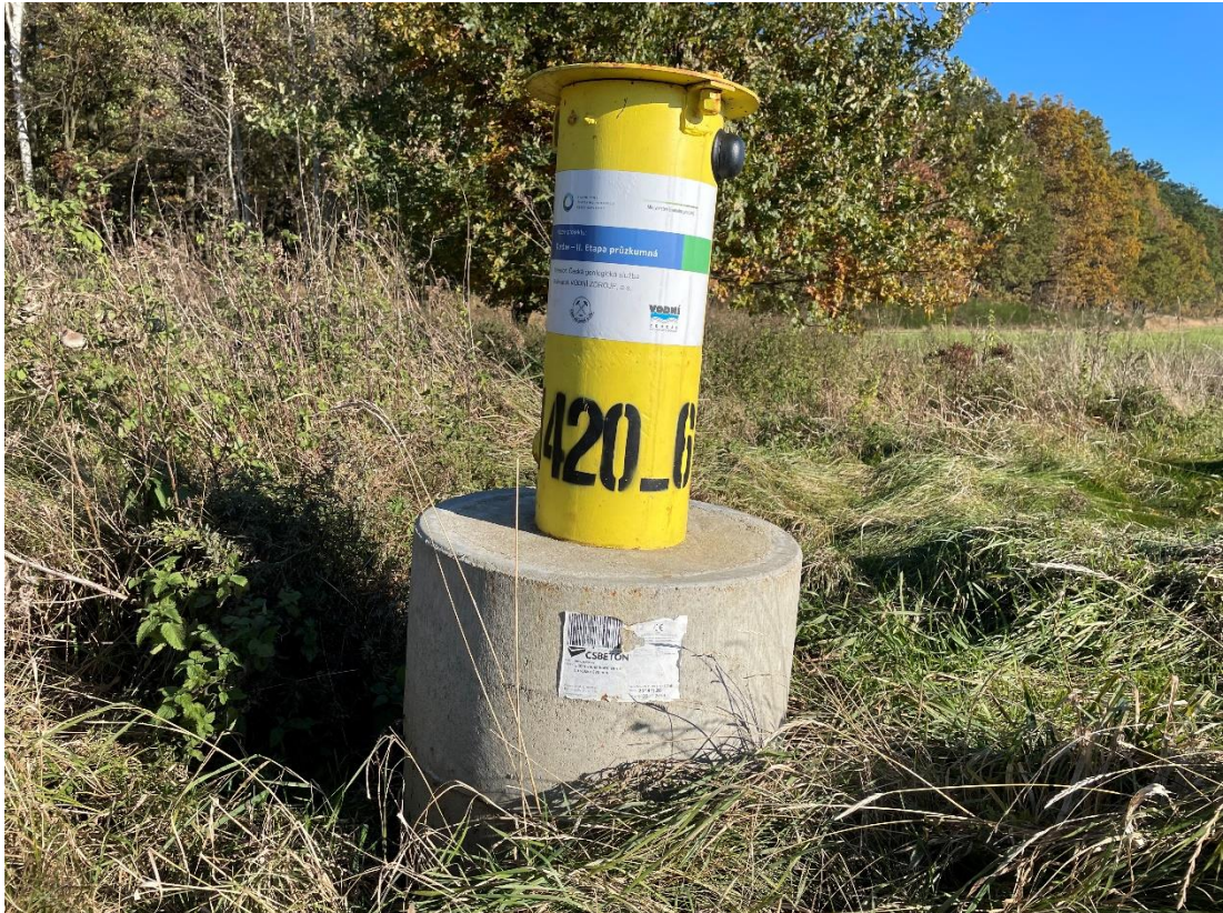
Příloha 6: Nový monitorovací vrt podzemní vody vybudovaný v rámci projektu ČGS "Turów - II. Etapa průzkumná" (foto autor – 28. 10. 2021).
