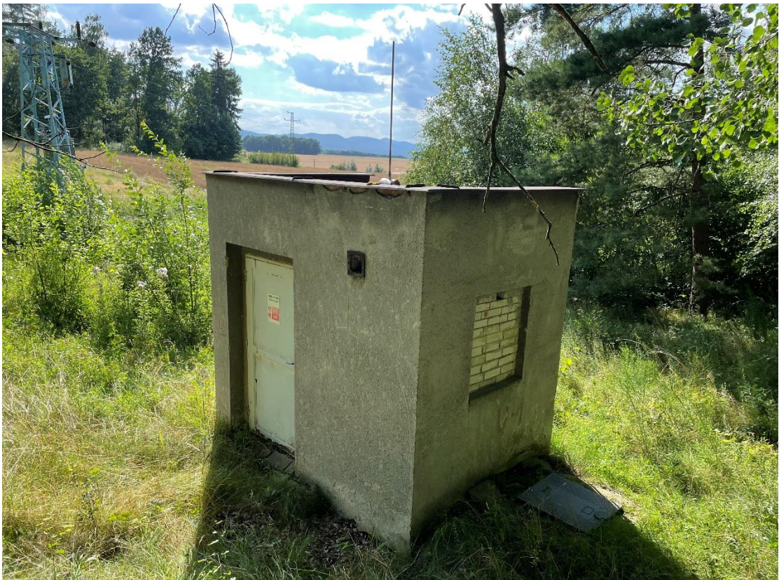
Příloha 12: Objekt jímacího vodojemu Uhelná (foto autor - 29. 7. 2021).
