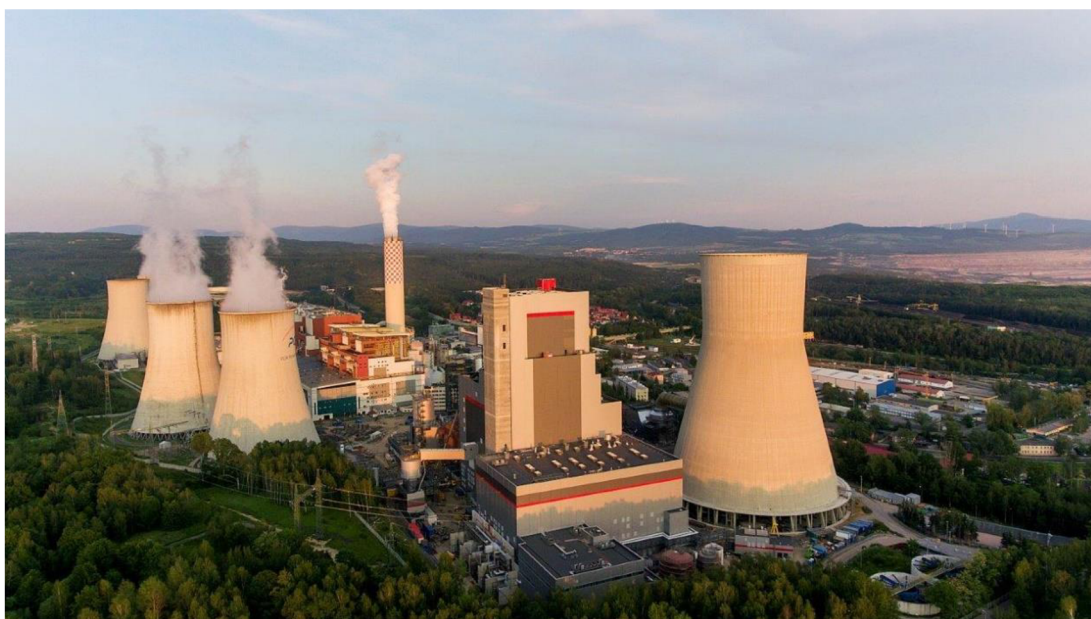
Příloha 4: Pohled na elektrárnu Turów. V předu je nová chladicí věž a nový blok č. 7, za ním pak starší bloky a objekty. Zalesněný svah za elektrárnou je zrekultivovaná vnější výsypka, vpravo od ní je vidět část jámy povrchového dolu (PGE, 2021a).
