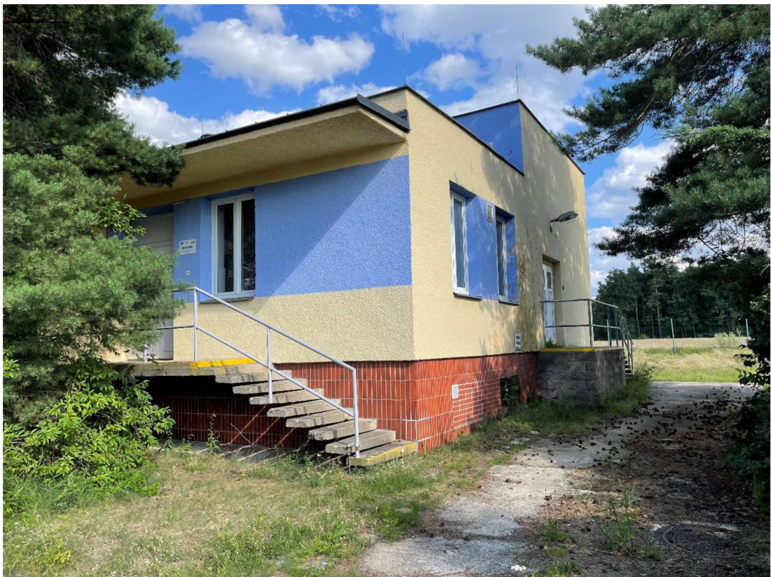
Příloha 13: Úpravna vody v Uhelné (foto autor - 29. 7. 2021).
