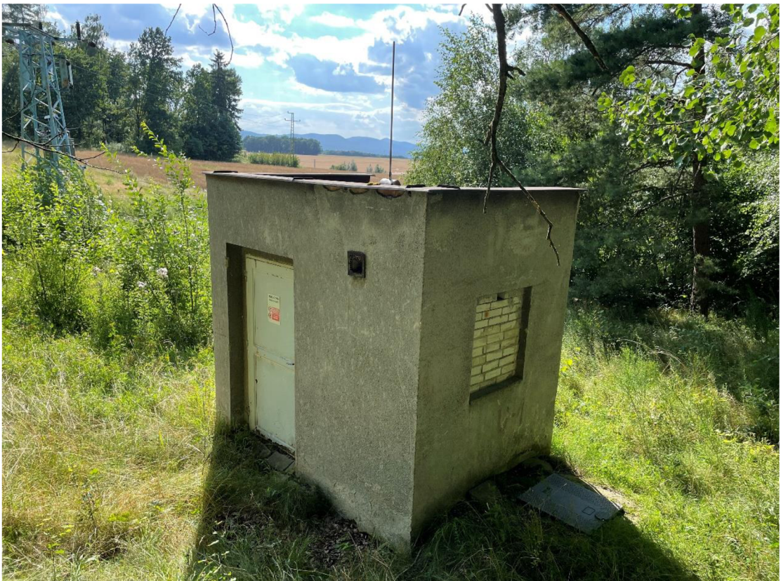
Příloha 12: Objekt jímacího vodojemu Uhelná (foto autor - 29. 7. 2021).
