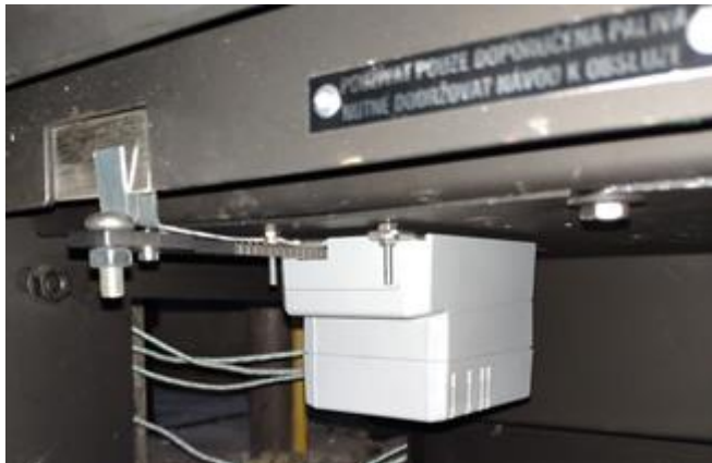
Obr. 70 Lineárny motor pre ovládanie množstva privádzaného sekundárneho vzduchu
