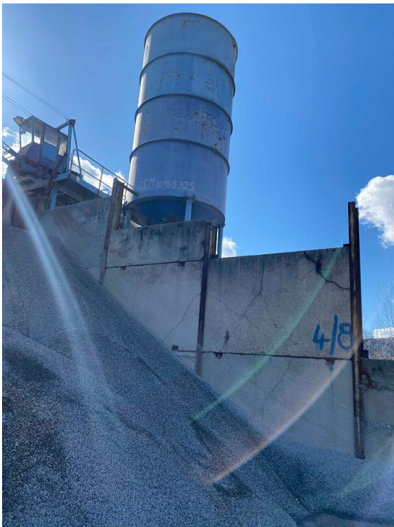
Obr. 2. 10 Skladovanie cementu v sile
