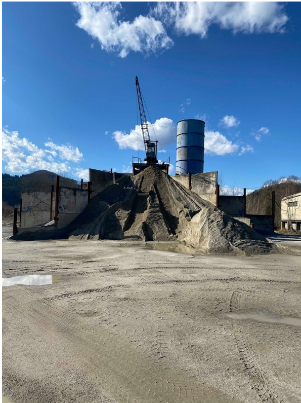
Obr. 2.5 Miešacia linka PZ Betontrans
