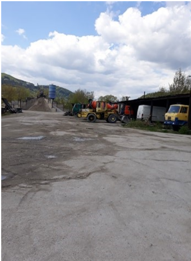
Obr. 2.1 Areál PZ Betontrans
