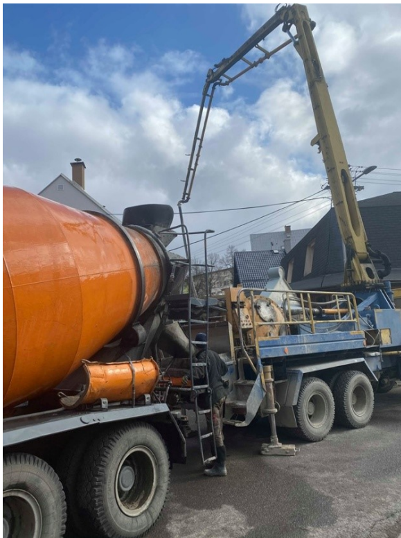
Obr. 2.8 Preprava betónovej zmesi z domiešavača cez rameno pumpy
