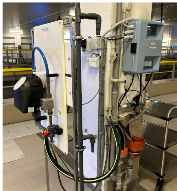
Obr. 5.5 Měřící technika hodnot při odtoku vody z pískových filtrů [autor]
