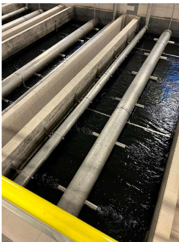
Obr. 5.7 Filtr s granulovaným aktivním uhlím [autor]
