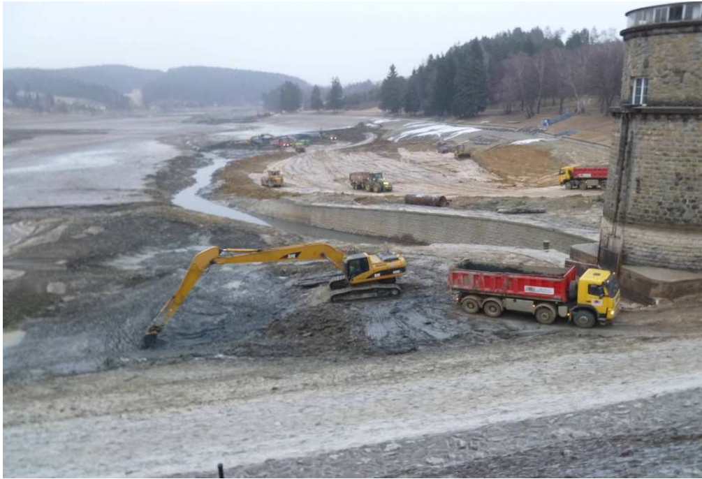
Obr. 1 Těžba sedimentů ve vodní nádrži Luhačovice, březen 2013 (zdroj: http://www.pmo.cz )
