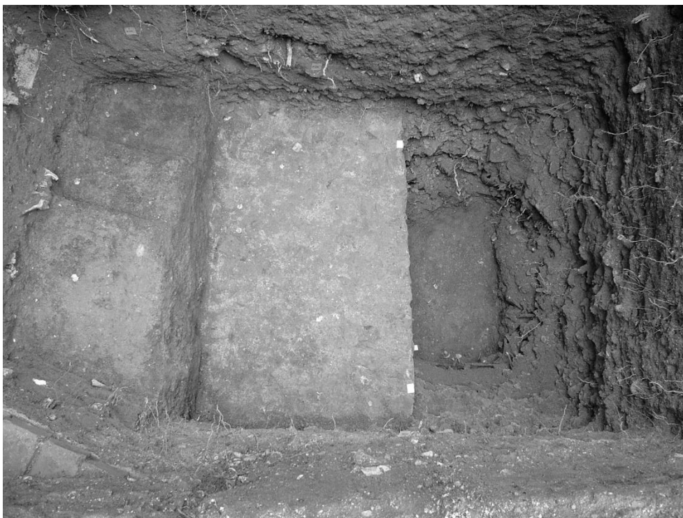
38 – kamenné zdivo samostatně stojící věže na severní straně kostela sv. Mikuláše, sonda S2/2005 (foto J. Šindelář)
