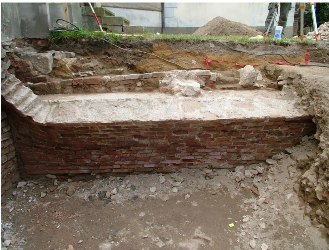
61 – ubourané zaklenuté prostory v sondě po začištění, sonda S1/2005 vyměřená jižně od kaple Smrtných úzkostí Páně (foto J. Šindelář)
