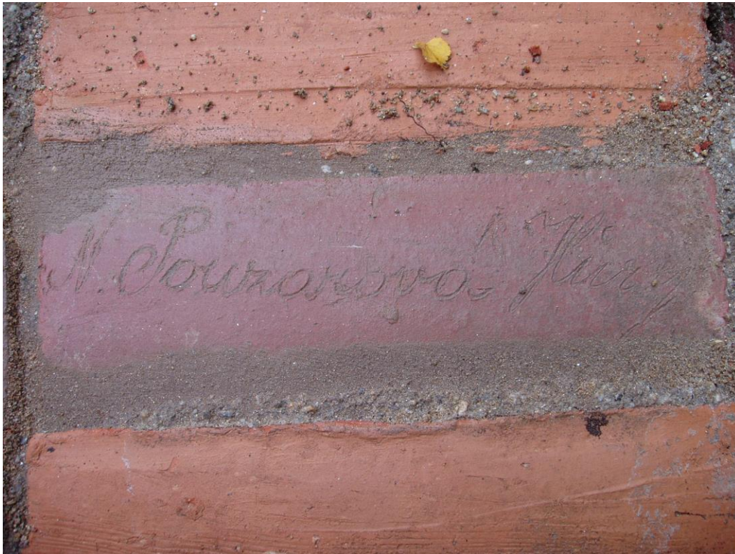
84 – detailní pohled na jméno a místo donátora nebo výrobce cihel speciálních rozměrů na výstavbu odzdušňovacího kanálku kolem kostela sv. Mikuláše (foto J. Šindelář)
