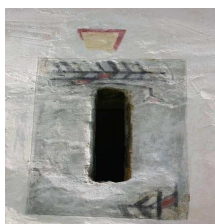
Větrací otvor špýcharu
