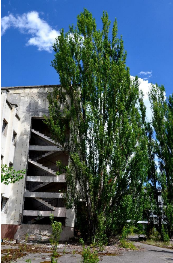
Obr. 6 a 7 – Vliv vegetace na technický stav budov
