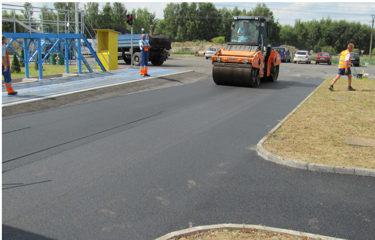
Obr. č. 21 Hutnění zkušebního úseku
