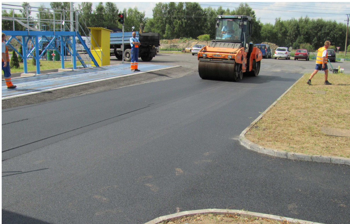
Obr. č. 21 Hutnění zkušebního úseku
