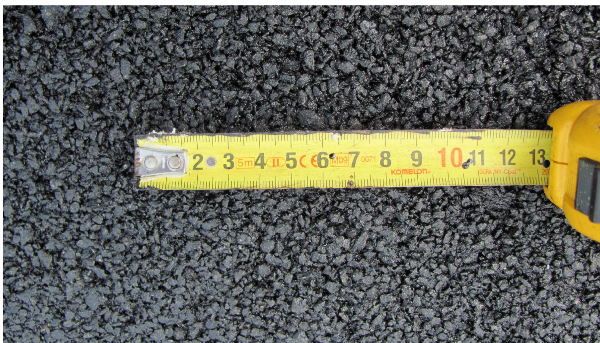
Obr. č. 22 Povrch vozovky z BBTM 5B
