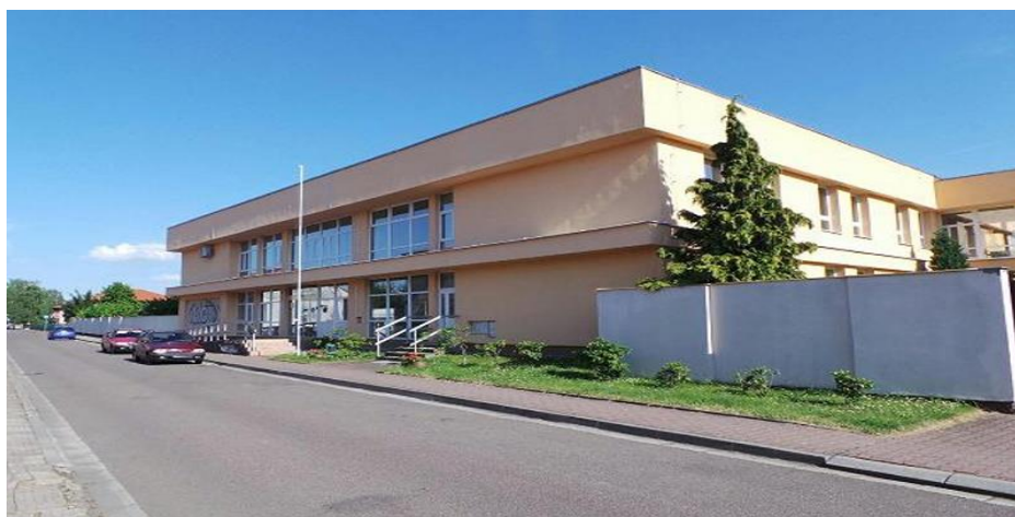
Obrázek 2 - Domov sociálních služeb Slatiňany – pohled na hlavní budovu
