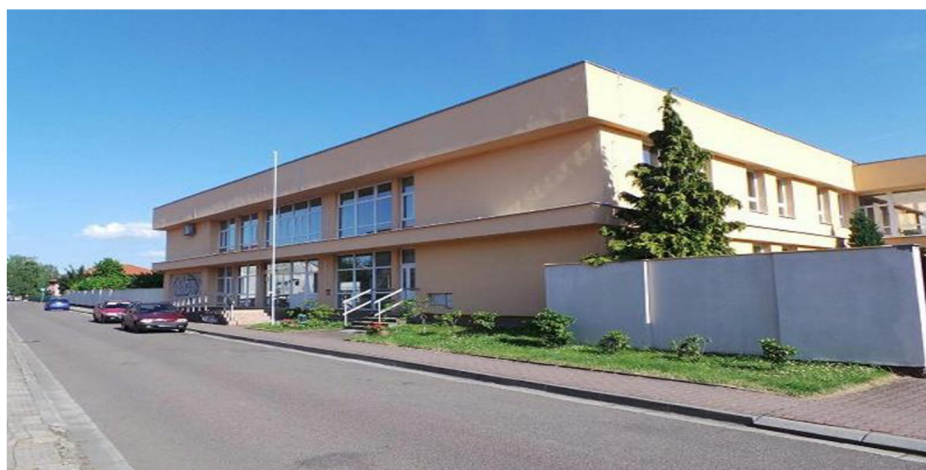
Obrázek 2 - Domov sociálních služeb Slatiňany – pohled na hlavní budovu
