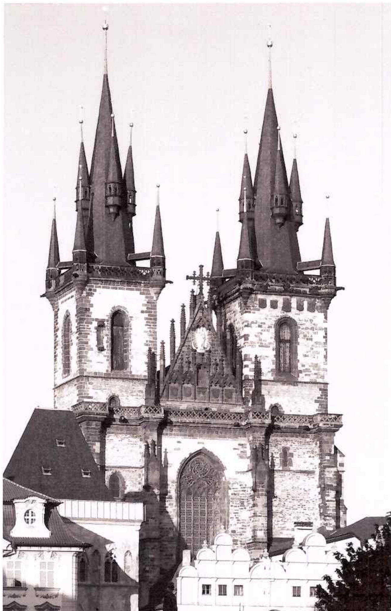
1. Praha, kostel Panny Marie před Týnem, západní průčelí. Foto: aut.
