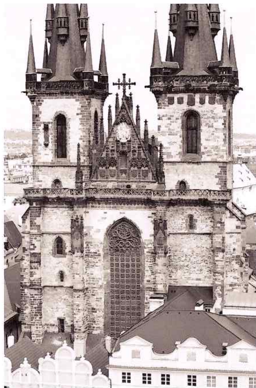
142. Praha, kostel Panny Marie před Týnem, západní průčelí. Foto: aut.
