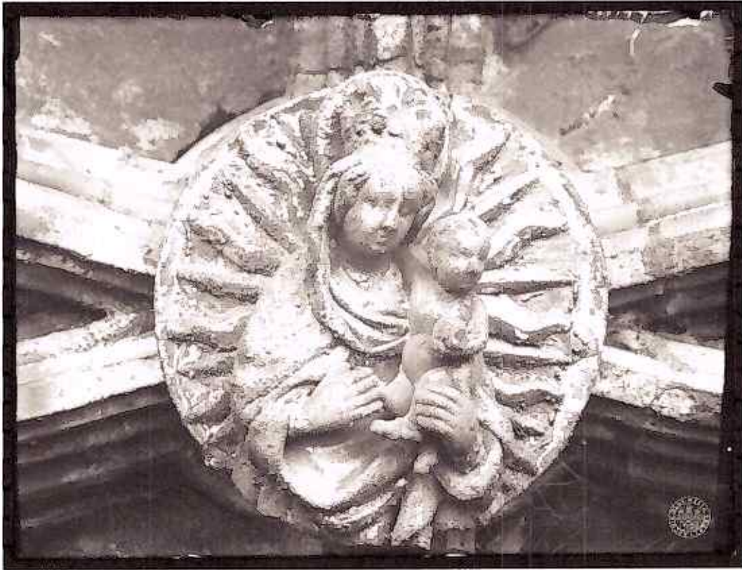
55. Jan Kříženecký, Praha, kostel Panny Marie před Týnem, svorník klenby severní předsíně, 18. června 1906. AHMP, SF, sign. XI 146. Foto: AHMP
