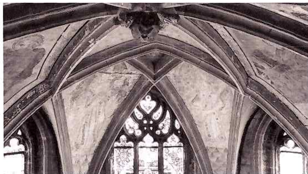
111. Slaný, kostel sv. Gotharda, žebra klenby presbytáře. Foto: Marek Pařízek
