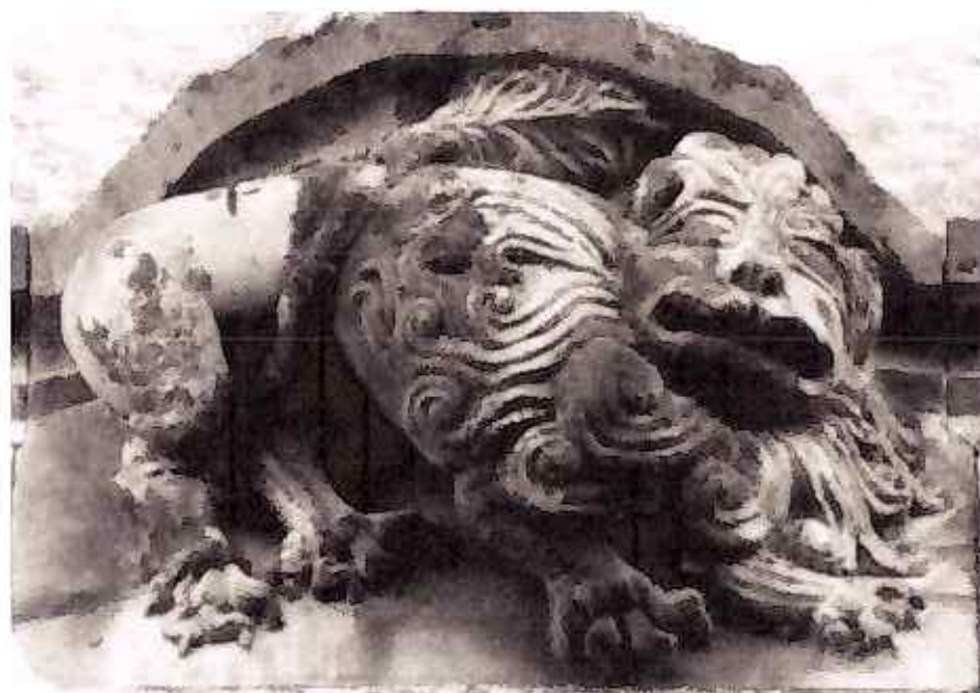
78. Praha, severní Malostranská věž Karlova mostu, konzoly pod středními nikami východního a západního průčelí. Foto: aut.
