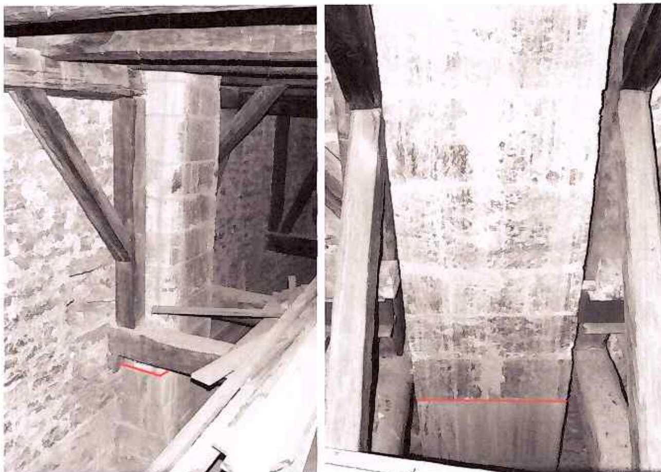
17. Praha, kostel Panny Marie před Týnem, vyznačení místa změny materiálu opěráků bočních stran hlavní lodi v úrovni korunních říms bočních lodí, vlevo na jižní, vpravo na severní straně. Foto a kresba: aut.
