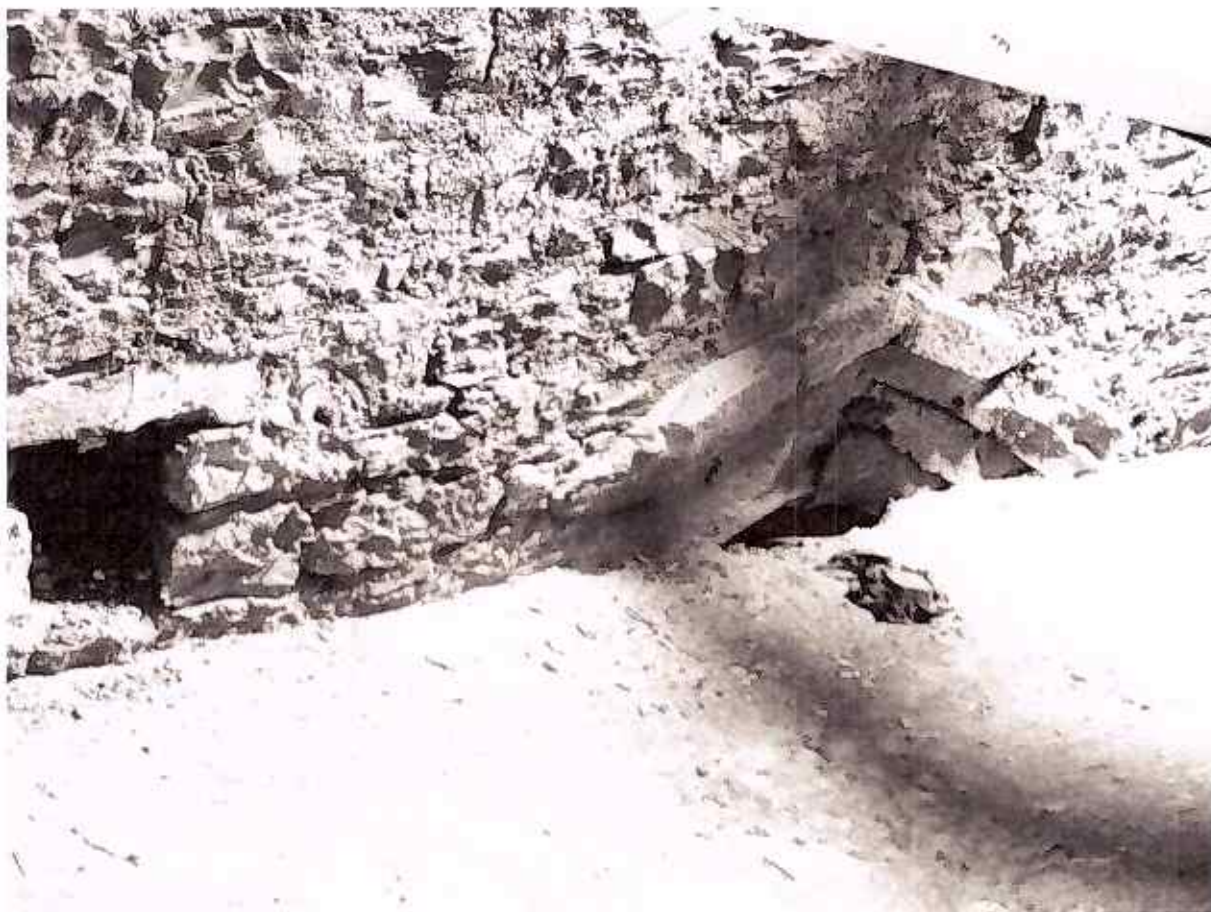
41. Praha, kostel Panny Marie před Týnem, záklenek okna závěru presbytáře v podkroví. Foto: aut.
