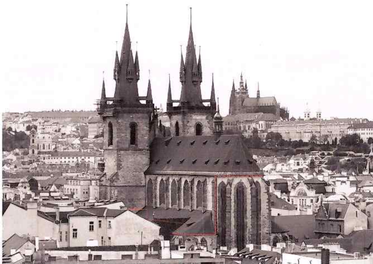
18. Praha, kostel Panny Marie před Týnem od jihovýchodu s přibližným vyznačením výškové úrovně dosažené na konci 14. století. Foto a kresba: aut.
