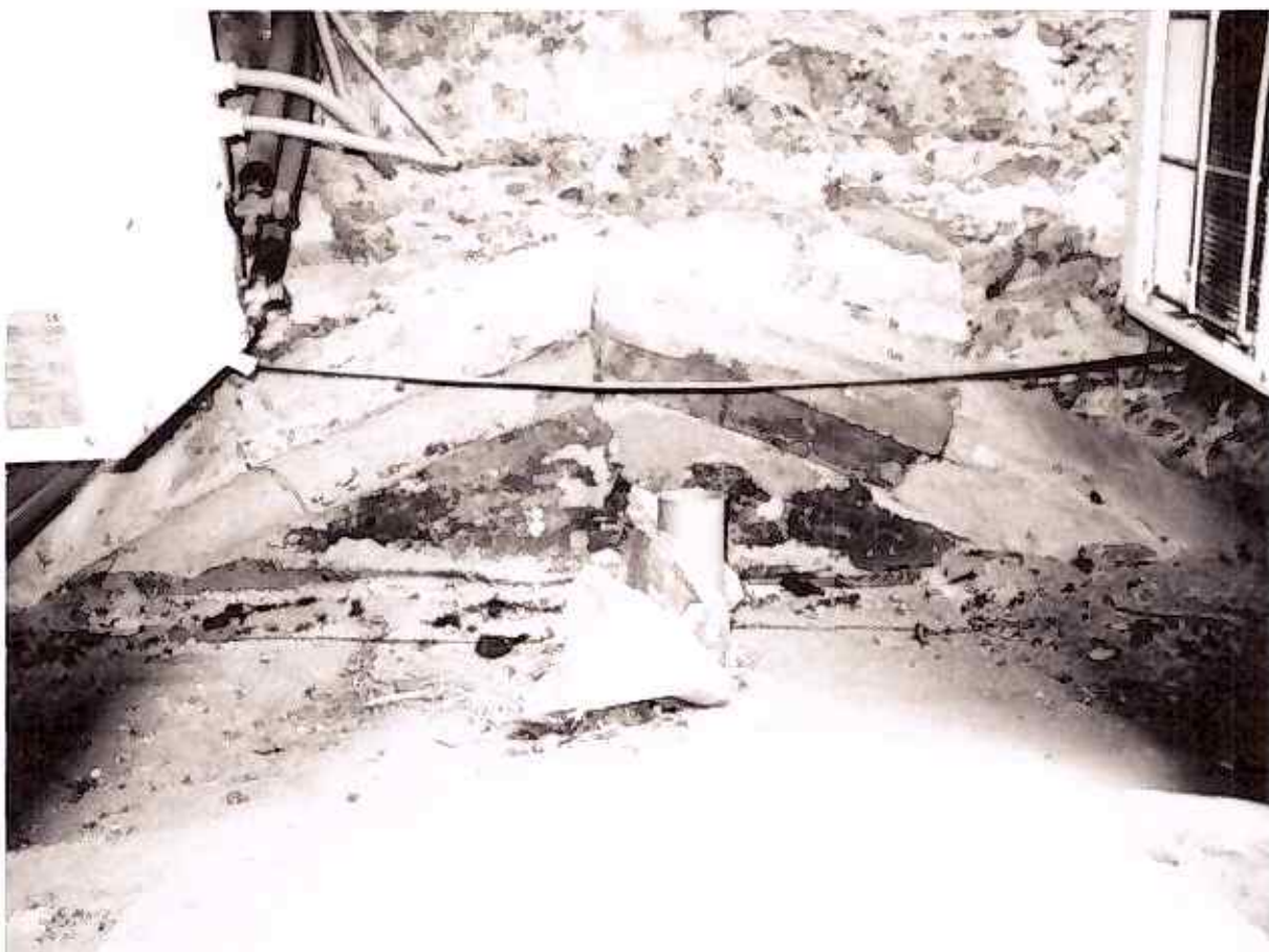
42. Praha, kostel Panny Marie před Týnem, přístěnné žebro hlavní lodi v podkroví. Foto: aut.
