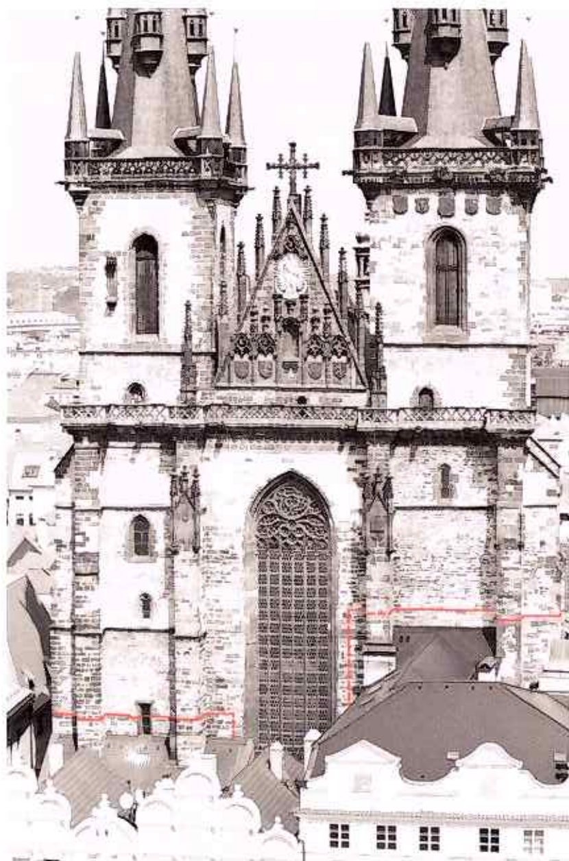
19. Praha, kostel Panny Marie před Týnem západní průčelí s vyznačením výškové úrovně dosažené do začátku 15. století. Foto a kresba: aut.
