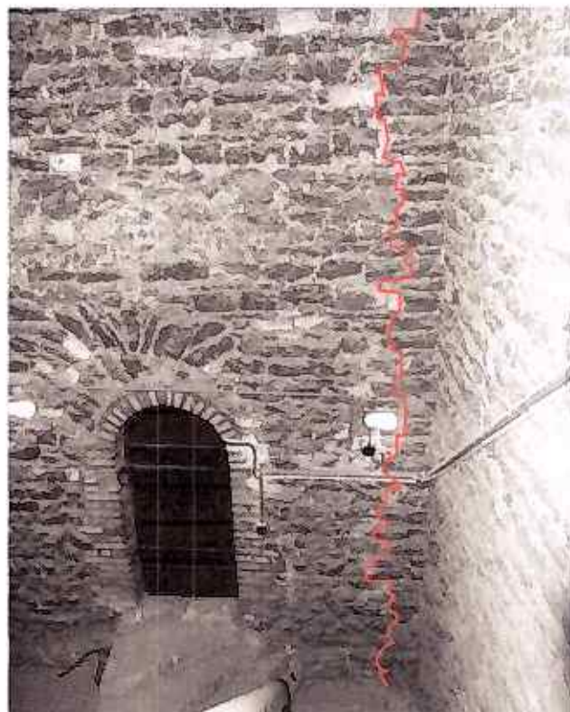
58. Praha, kostel Panny Marie před Týnem, jihovýchodní kout severní věže s vyznačením spáry připojení věže k severní zdi hlavní lodi. Foto a kresba: aut.
