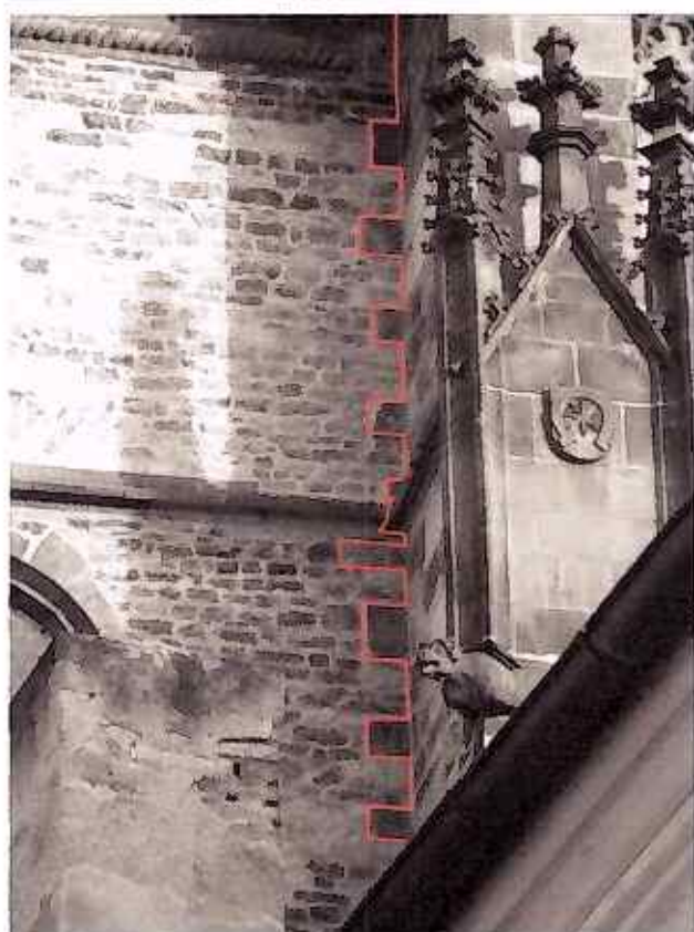
57. Praha, kostel Panny Marie před Týnem, západní průčelí severní věže s vyznačením spáry připojení k hlavní lodi. Foto a kresba: aut.
