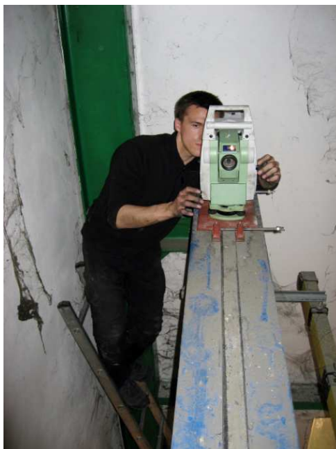
Obr. 5-8: Postavenie merača na rebríku
