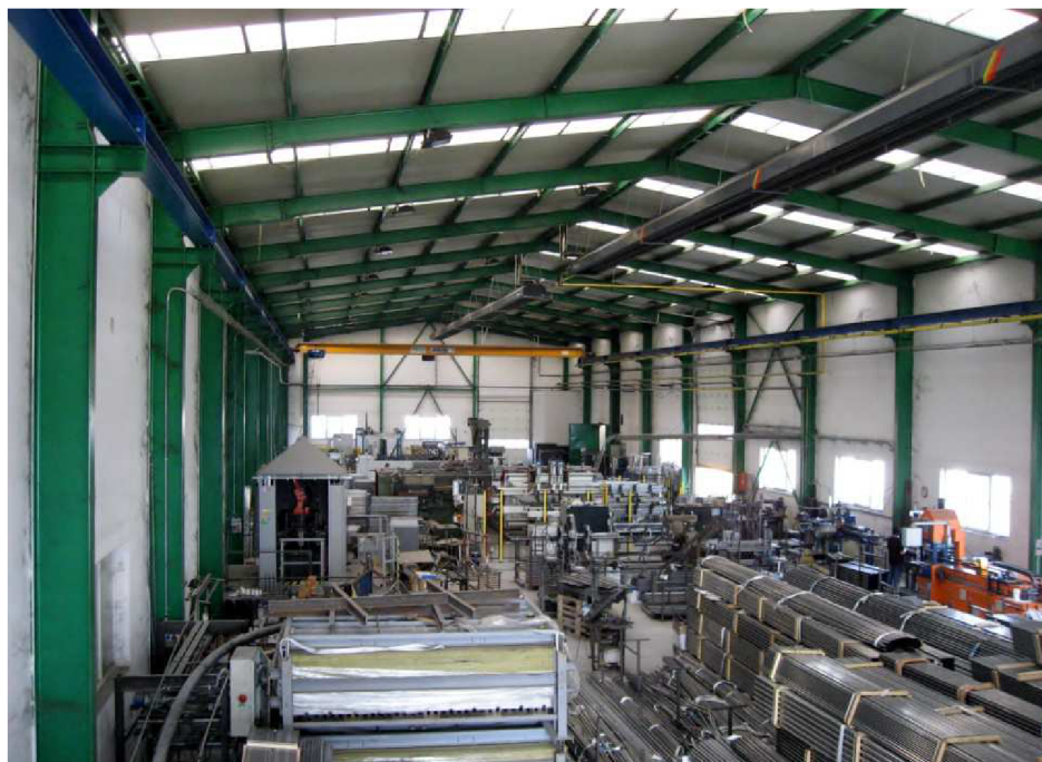
Obr. 5-2: Žeriavová dráha vo firme Thermal Trend spol. s r.o.
