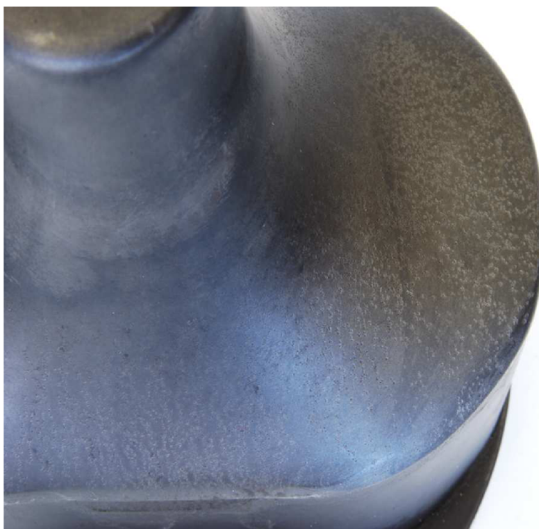
Obr. P1.2 Detail poškození
