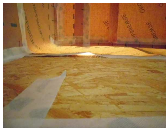
Obrázek 93 Nekvalitní prolení konstrukcí.
