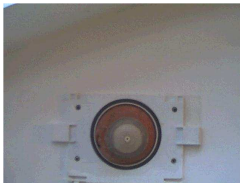
Obrázek 47 Utěsnění průchodu lokálního prvku rekuperace.
