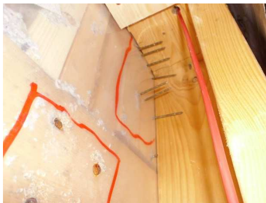
Obrázek 85 Porušená parozábrana.
