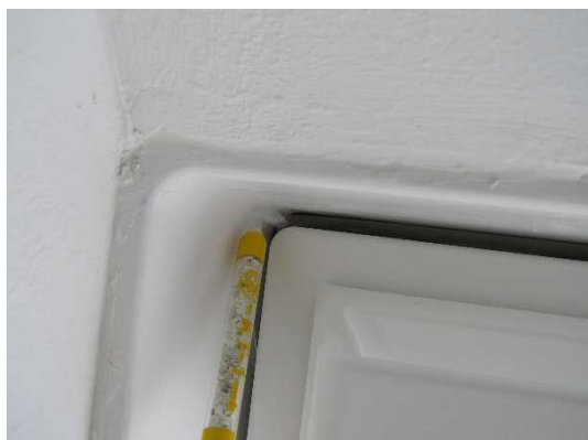
Obrázek 75 Detail celoobvodového těsnění.
