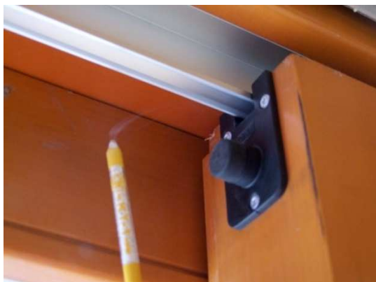
Obrázek 74 Horní kování posuvných dveří.
