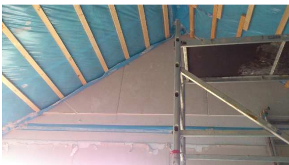
Obrázek 43 Zabezpečení vzduchotěsnicí vrstvy.
