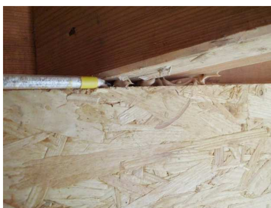
Obrázek 89 Napojení stropní a obvodové konstrukce.
