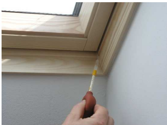
Obrázek 76 Dřevné střešní okno.
