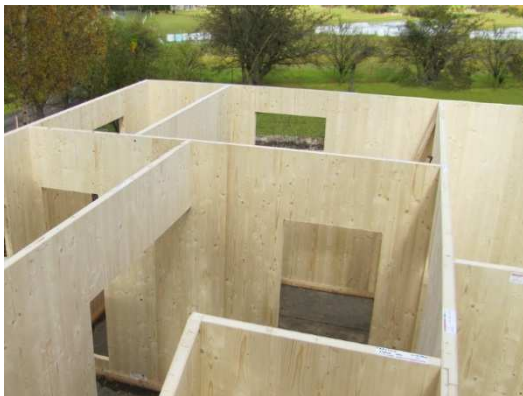
Obrázek 18 Stavba z CLT panelu. [71]
