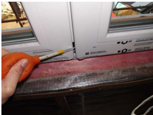
Obrázek 72 Plastové okno na sraz.
