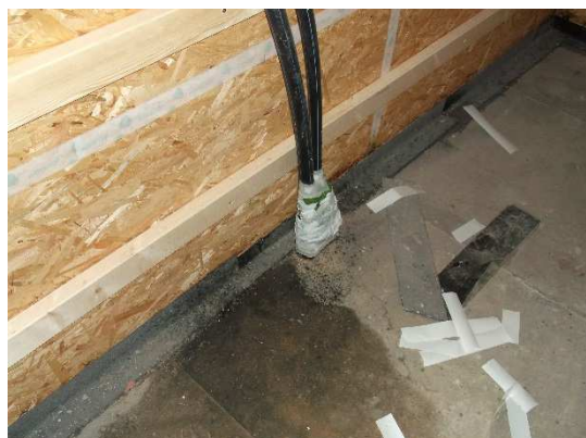
Obrázek 83 Napojení OSB desky na podlahovou konstrukci pomocí butylového pásku.
