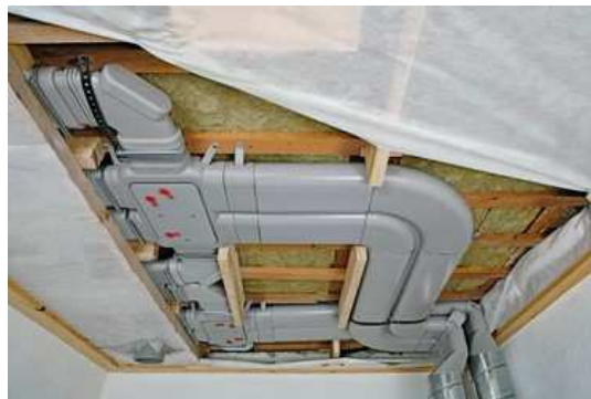
Obrázek 29 Rozvody centrální rekuperace. [67]
