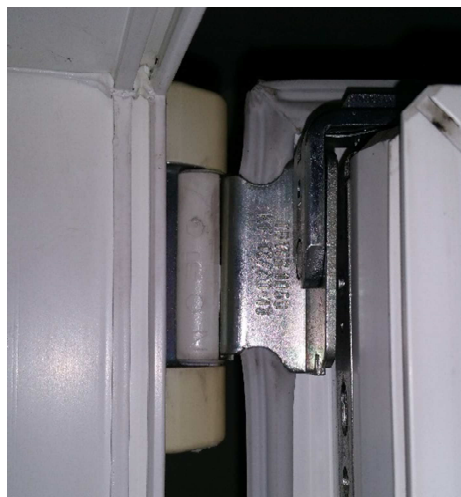
Obrázek 70 Horní pant u sklopně otvíravých otvorových výplní.
