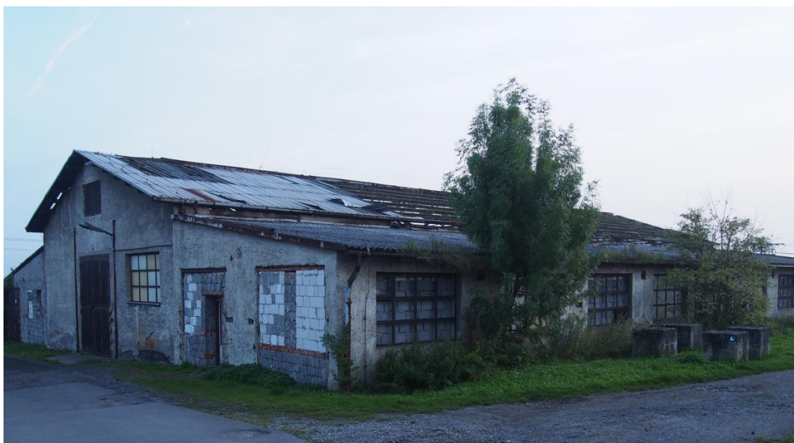
Příloha č. 14: Současná podoba bývalé odchozny býků v Hošťálkovicích
