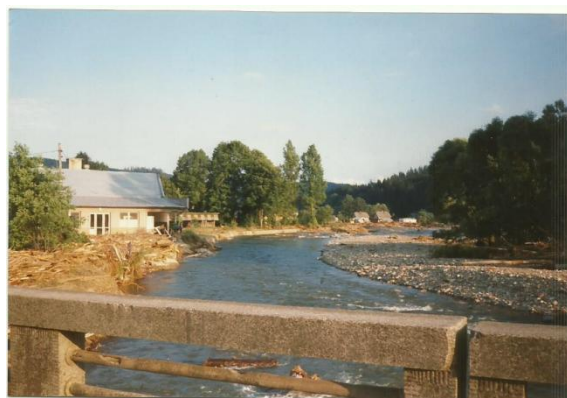
Obr. 54: Pohled z hlavního mostu Zdroj: (Vlastní fotografie)
