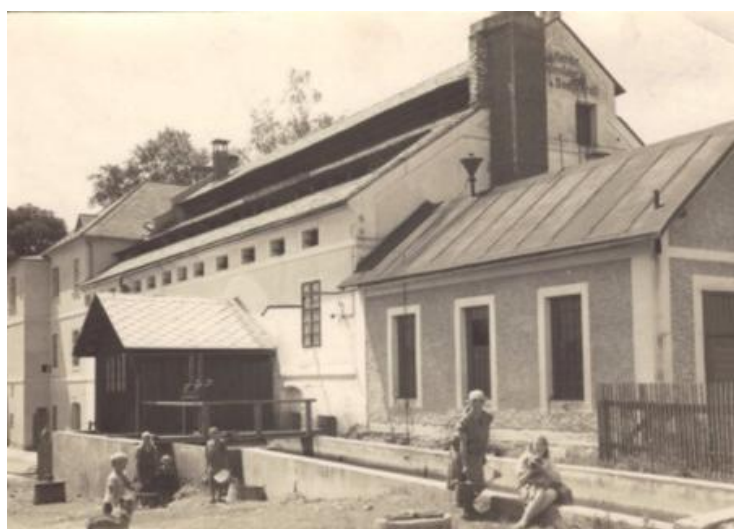
Obr. 25: Továrna a obytná část s vybetonovaným korytem náhonu – po r. 1928 Zdroj: (Archiv spol. Actaea)
