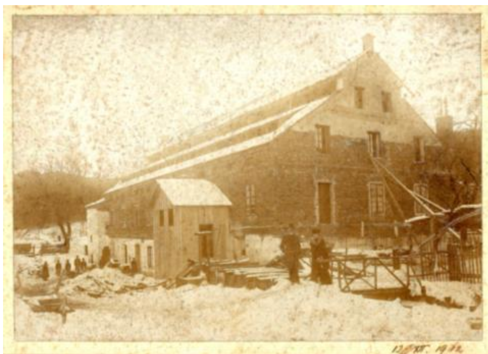
Obr. 23: Stavba továrny na lepenku 1912, manželé Herdinovi Zdroj: (Archiv spol. Actaea)
