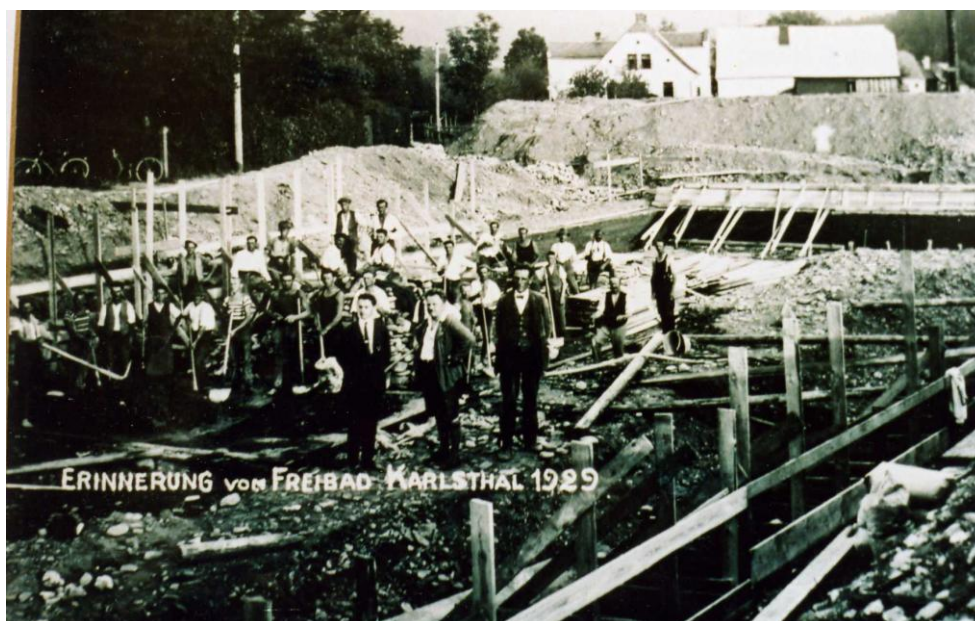
Obr. 37: Stavba koupaliště 1929 Zdroj: (Archiv spol. Actaea)
