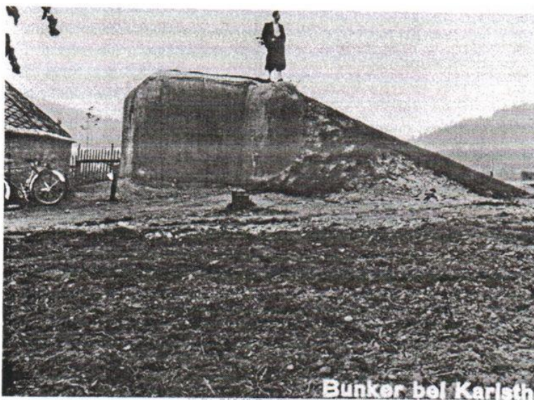
Karlsthäl – Bunker der tschechischen Befestigungslinie 1938
