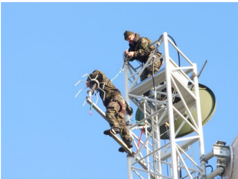
Obr. 3.5 Instalace nového systému
