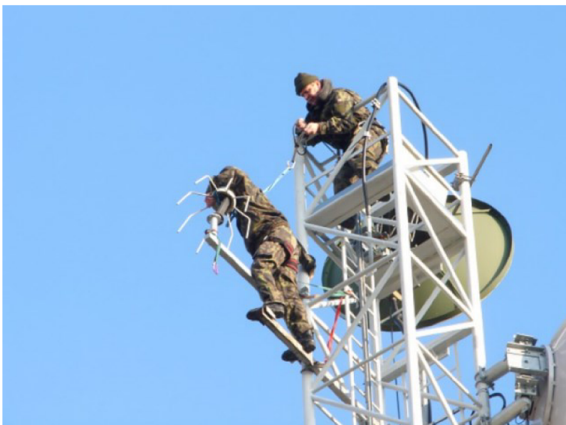
Obr. 3.5 Instalace nového systému
