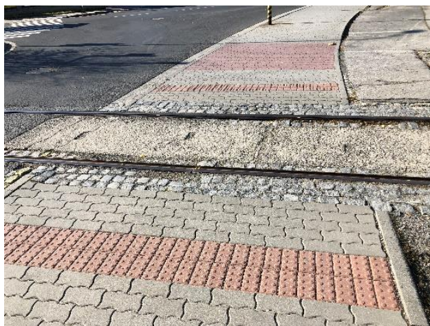
Obrázek 214: Detail železničního přejezdu
