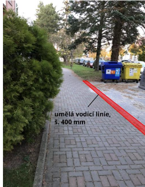
Obrázek 153: Přerušení přirozené vodící linie
