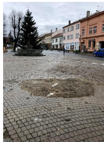
Obrázek 103: Chybějící dlažba
