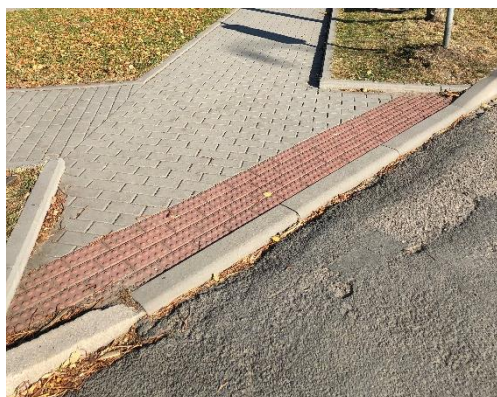
Obrázek 23: Varovný pás na kraji chodníku
