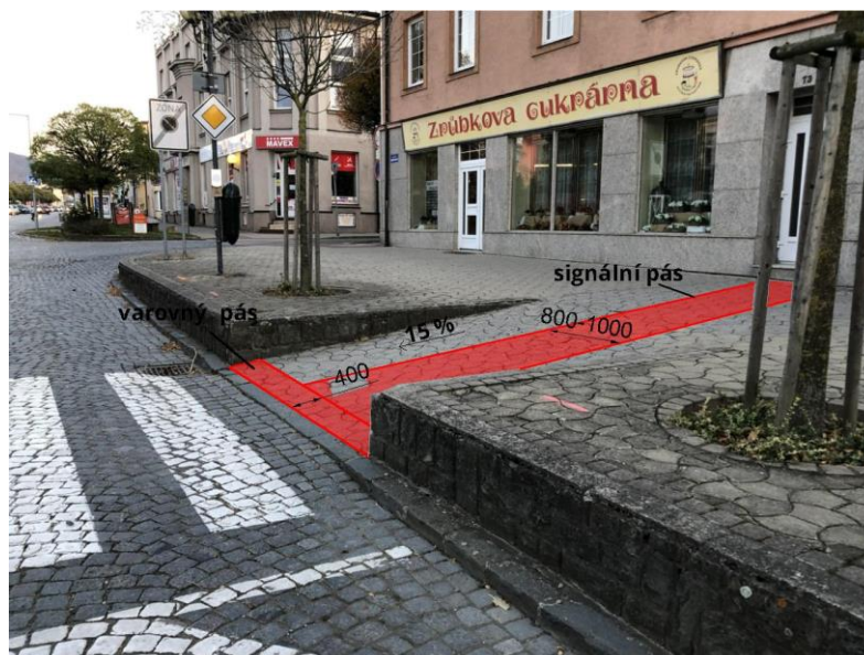
Obrázek 83: Vodící linie u přechodu pro chodce
