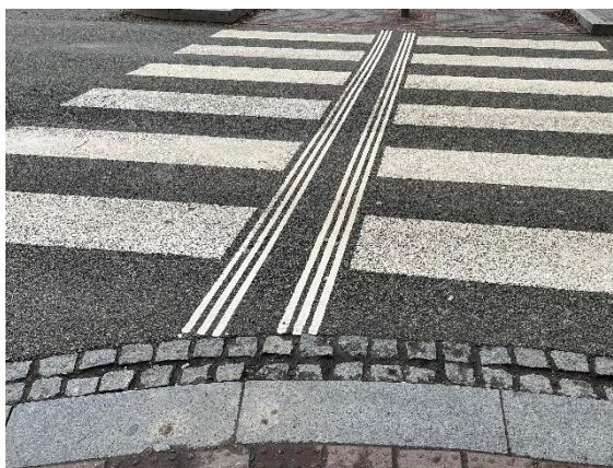
Obrázek 22: Vodící pás přechodu
