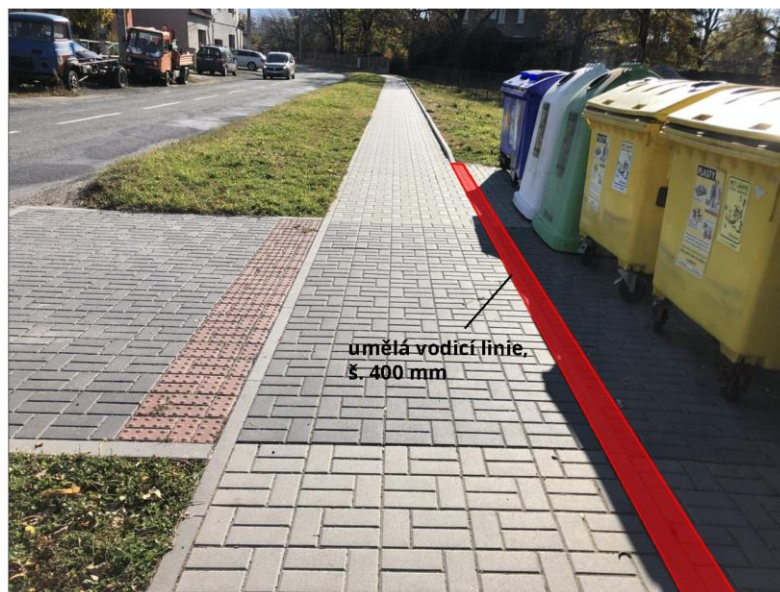
Obrázek 108: Přerušení přirozené vodící linie
