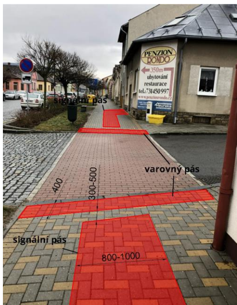
Obrázek 67: Místo pro přecházení přes ulici Slavkovská
