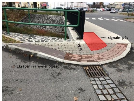
Obrázek 118: Ukončení chodníku na mostu
