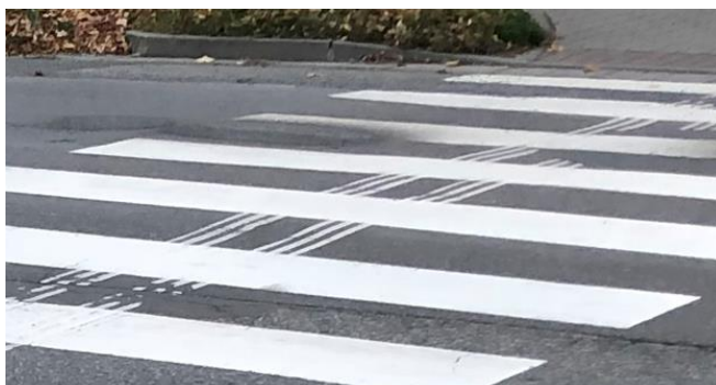
Obrázek 195: Vodící pás přechodu
