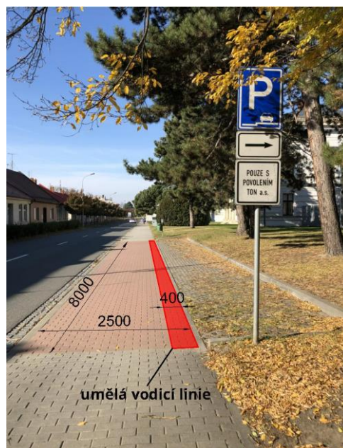
Obrázek 216: Přerušení vodící linie
