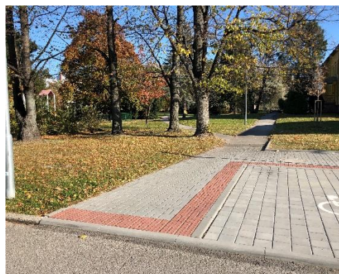
Obrázek 24: Varovný pás
