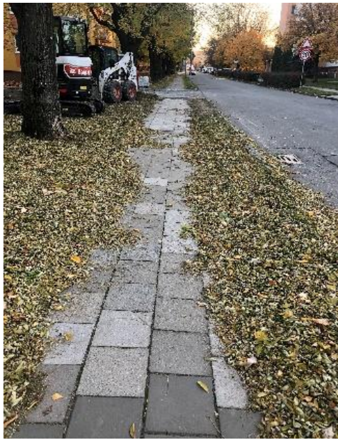
Obrázek 181: Zanesená vodící linie
