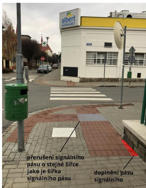
Obrázek 88: Vodící linie u přechodu pro chodce
