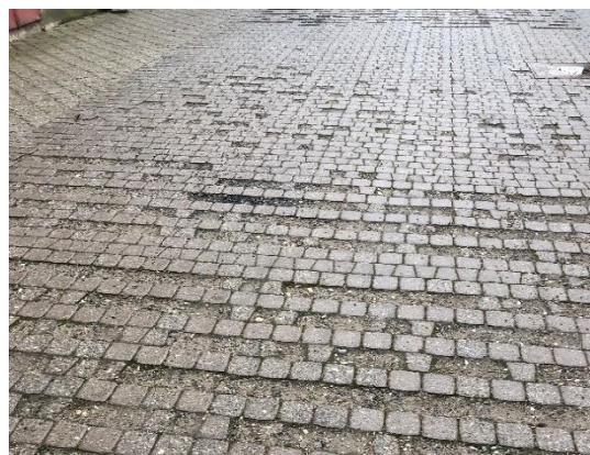
Obrázek 95: Chybějící dlažba
