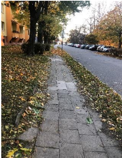
Obrázek 183: Zanesená vodící linie
