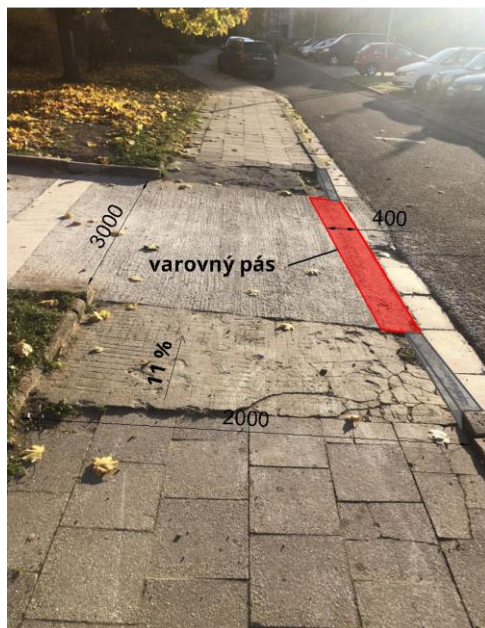
Obrázek 160: Sjezd s rampou
