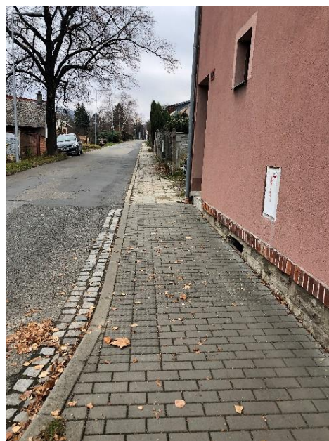
Obrázek 60: Varovný a signální pás
