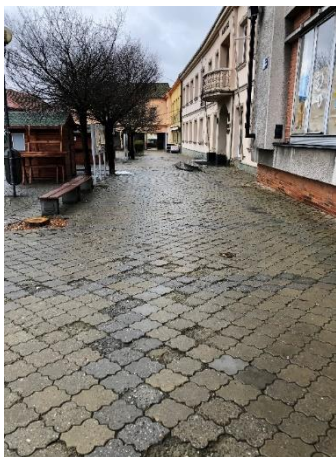
Obrázek 101: Špatný stav povrchu
