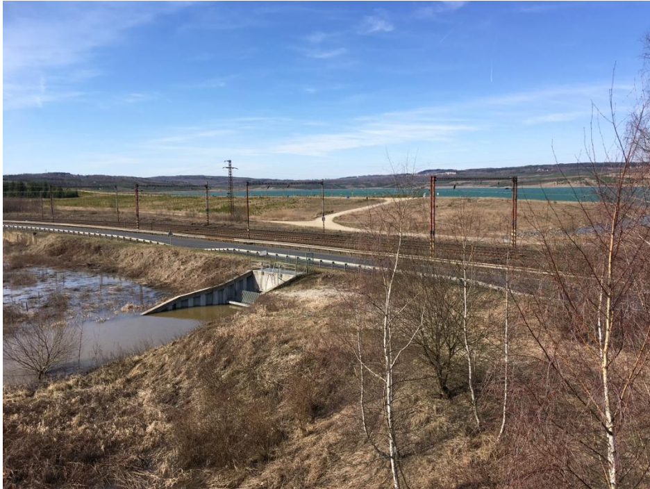
Foto: Napouštěcí objekt z Ohře.
