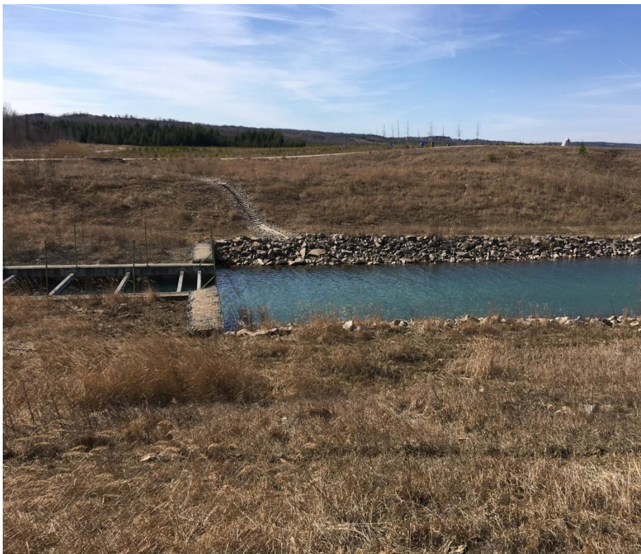
Foto: Napouštěcí objekt z Ohře - detail.
