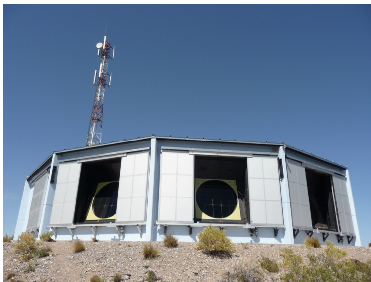
Obrázek 2.5: Budova fluorescenčního detektoru Los Leones (bezpečnostní clona odkryta z důvodu údržby). Převzato z [22].
