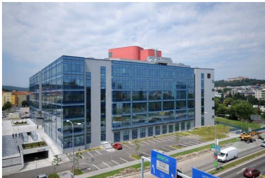
OBR. 2: Justiční areál v Brně
