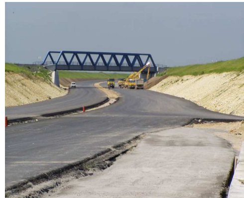
OBR. 1: E III – 3 Silnice I/6 Praha - Pavlov
