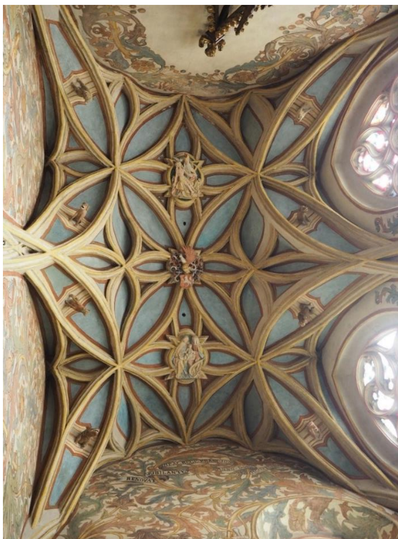
Obr. II. Klenba Špulířské kaple, 1506.
