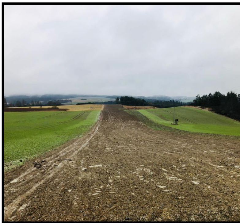
Obrázek 2 - Pohled na na krajinu po položení plynovodu GAZELA
