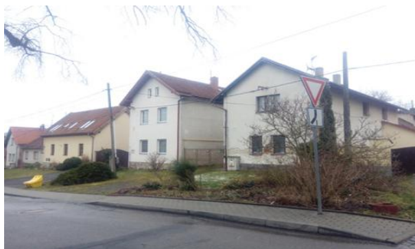
Obr. 71: Úsek č. 2 – čp. 4-41
