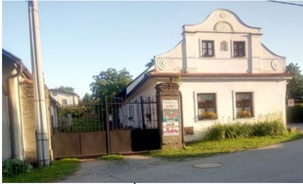
Obr. 67: Úsek č. 1 – čp. 1
