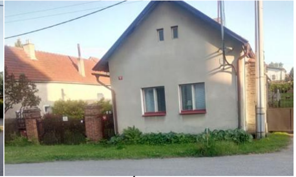
Obr. 68: Úsek č. 1 – čp. 3
