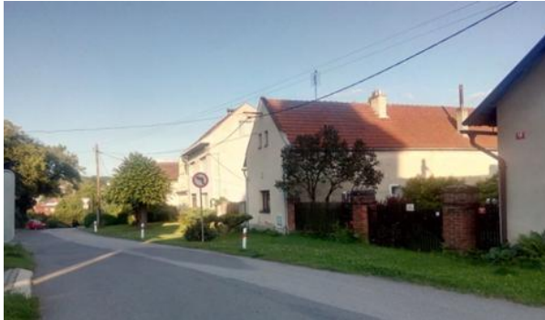
Obr. 69: Úsek č. 1 – čp. 46-3
