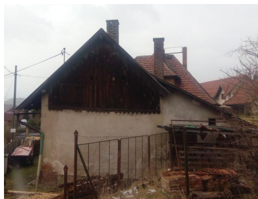
Obr. 24: Dochovaná dřevěná část domu
