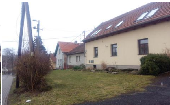
Obr. 72: Úsek č. 2 – čp. 41-5
