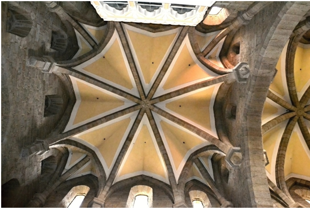
Obr. 10 - Osmidílná klenba chóru (Jakubíčková, 2015)
