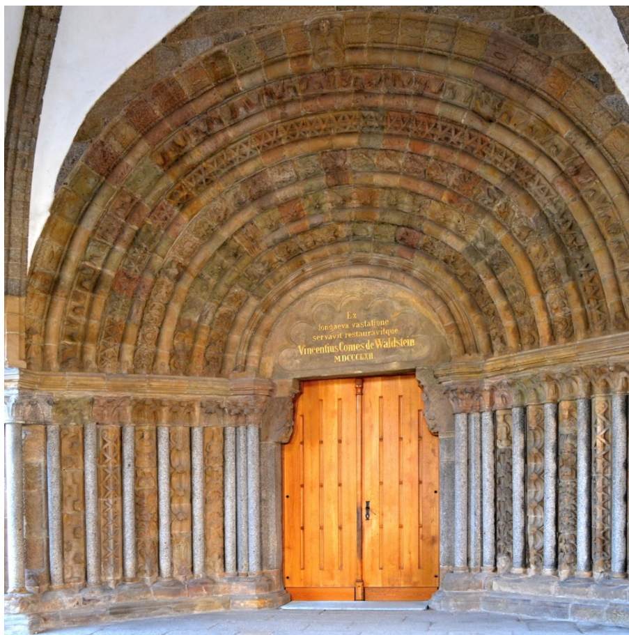
Obr. 9 - Portál severní předsíně - Brána rajska (Jakubičková, 2015)
