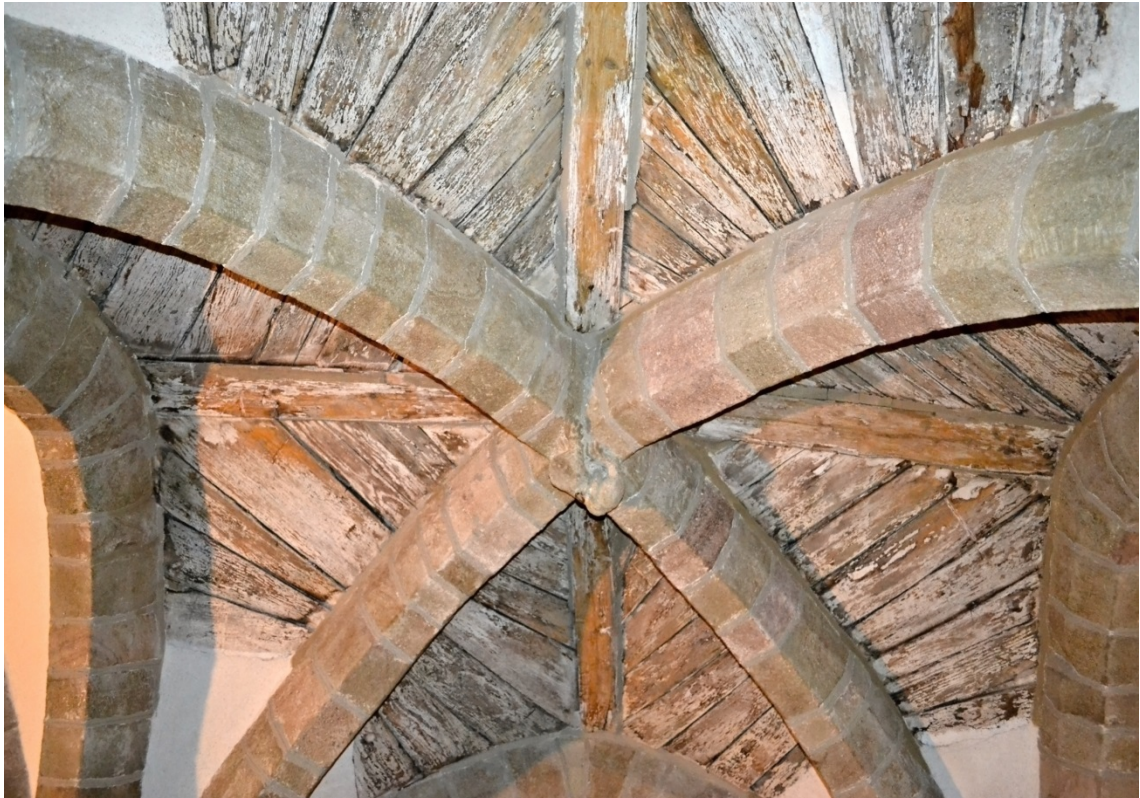
Obr. 12 - Část stropu krypty, "zkamenělé" dřevo. Vědeckými metodami určeno, že tato výdřeva je ze smrkového / jedlového dřeva, pokáceného mezi roky 1216 až 1226. (Jakubičková, 2015)
