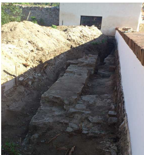
Obr. 15 - Stavební práce - část původních hradeb (Jakubičková, 2012)
