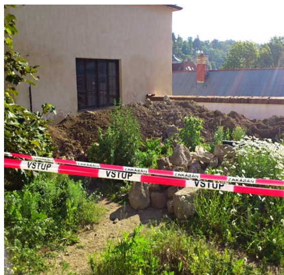
Obr. 14 - Stavební práce (Jakubičková, 2012)
