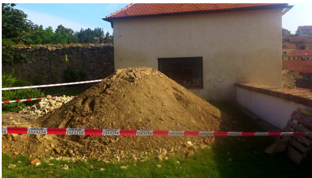
Obr. 17 - Rekonstrukce strážního domku r. 2013
