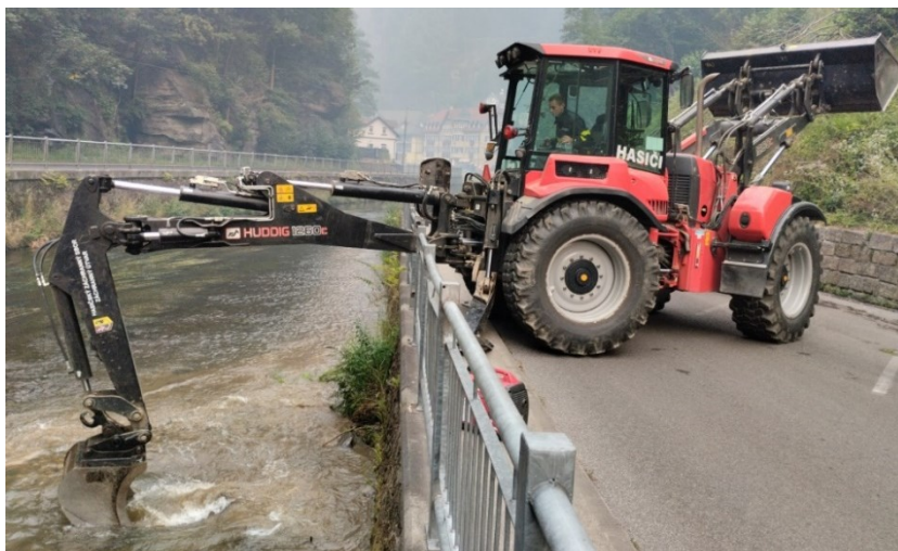
Obrázek 23: příprava čerpacího místa pro MČS 180/330K, zdroj: foto autor
