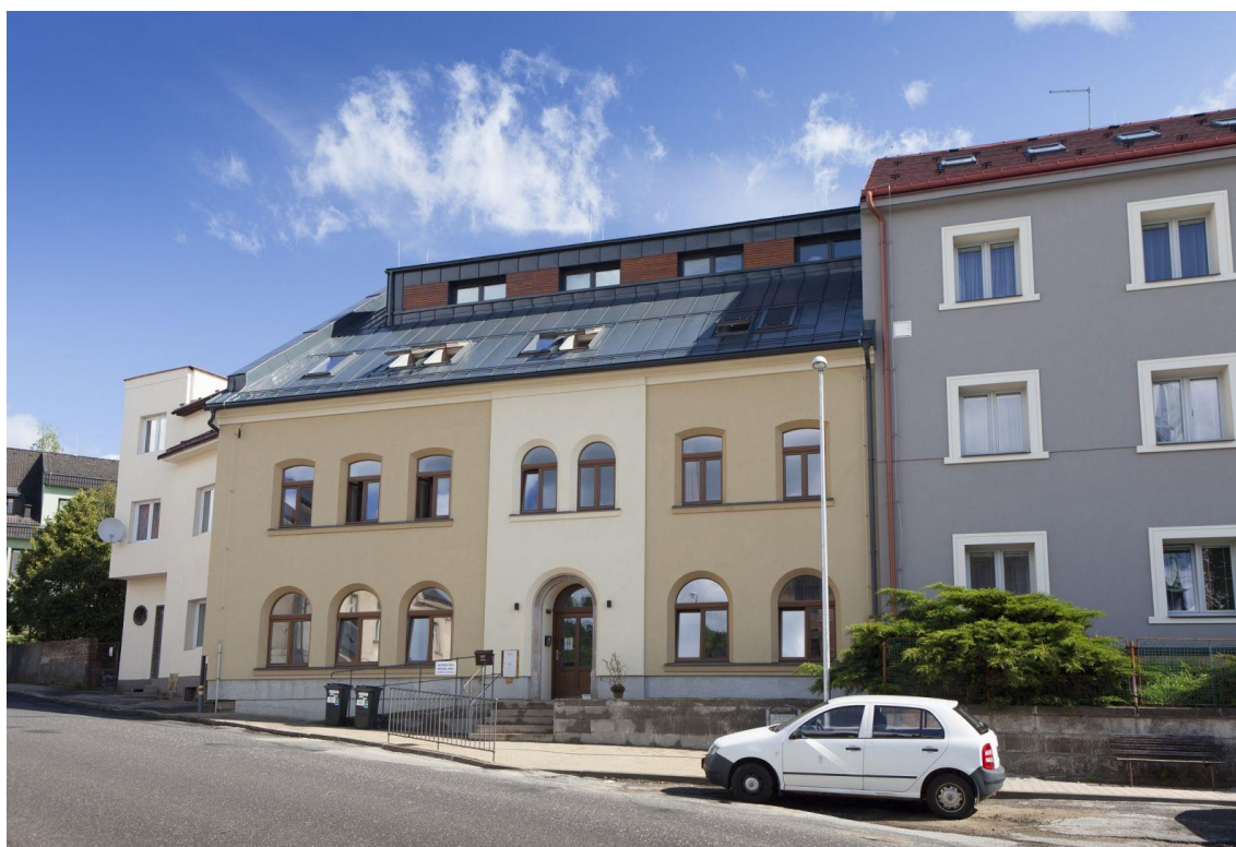
Nová vedlejší budova ZUŠ po rekonstrukci.
