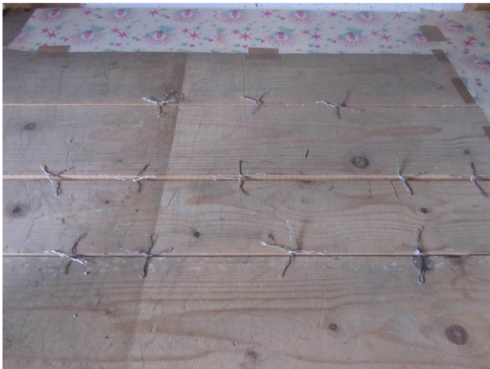
Obr. č. 19: Drátěné konstrukce pro zavěšení čápů do prostoru scény
