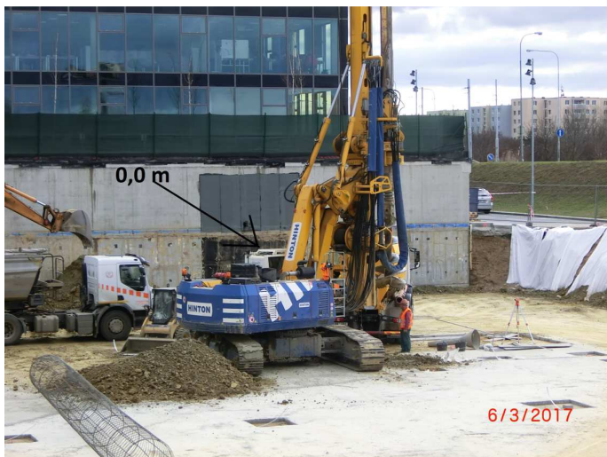
Obr. 7.3 Situace těžení - pilotážní souprava s umístěným hlukoměrem
