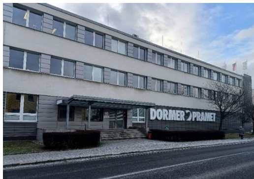
Obr. 2 Sídlo společnosti Dormer Pramet, s.r.o.
