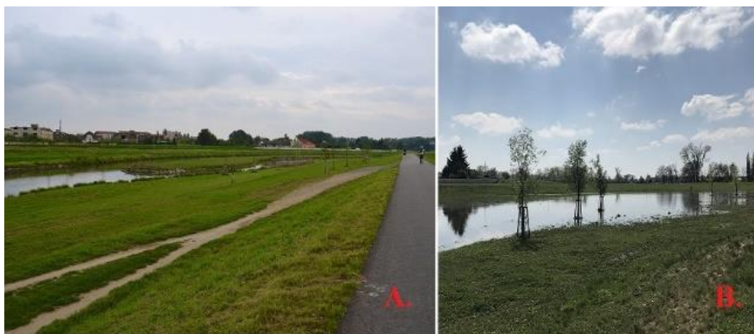
Obr. 19: Vlevo pohled na snížení levobřežní bremy a vpravo využití revitalizace při rozlivu vody (zdroj: vlastní zpracování)
