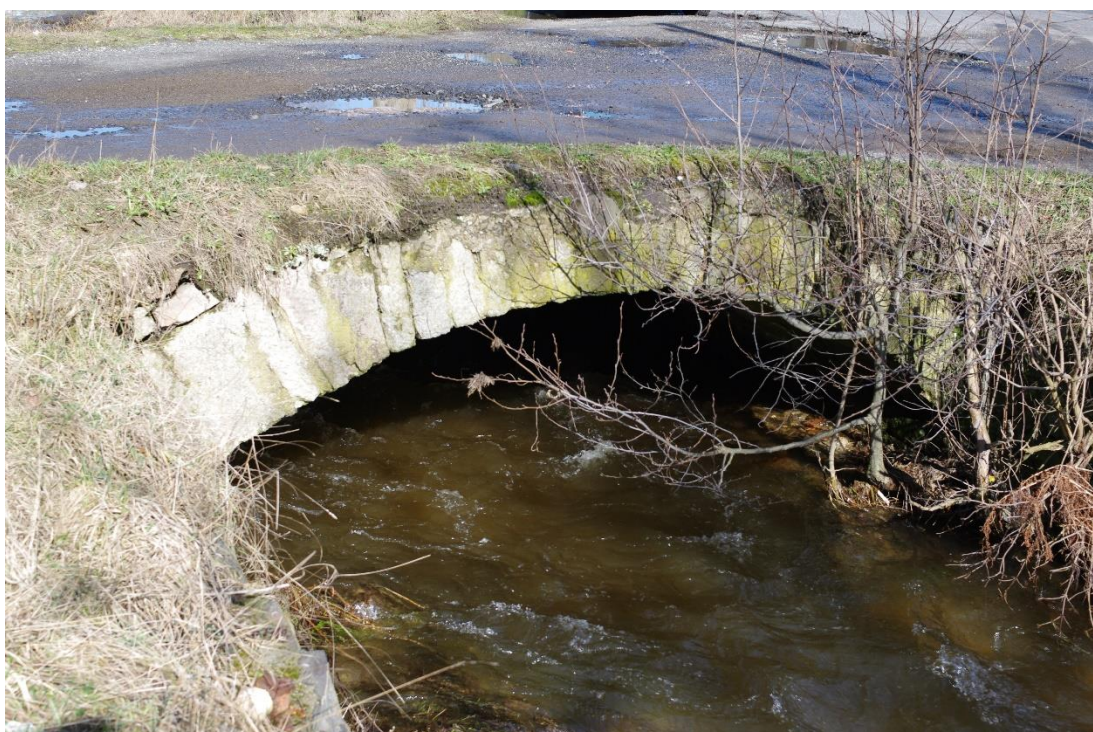
Příloha č. 8: Objekt č.18: silniční most – 10.56 ř. km
