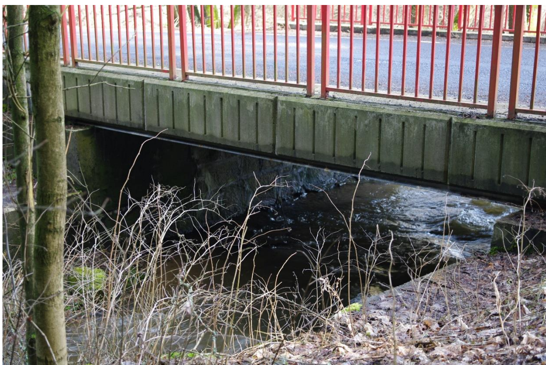
Příloha č. 6: Objekt č.13: silniční most – 6.21 ř. km
