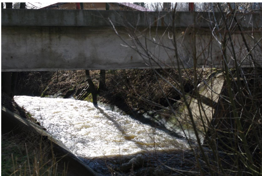
Příloha č. 4: Objekt č.8: betonový silniční most – 2.61 ř. km
