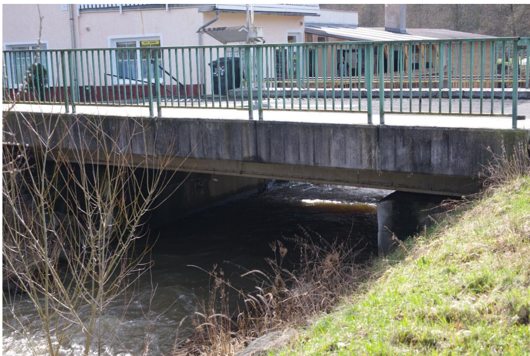
Příloha č. 3: Objekt č.5: betonový silniční most – 1.07 ř. km
