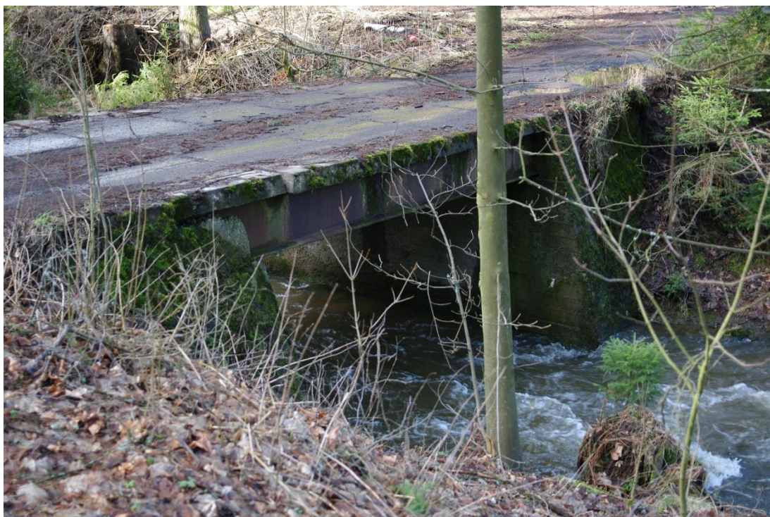
Příloha č. 7: Objekt č.14: most – 7.22 ř. km
