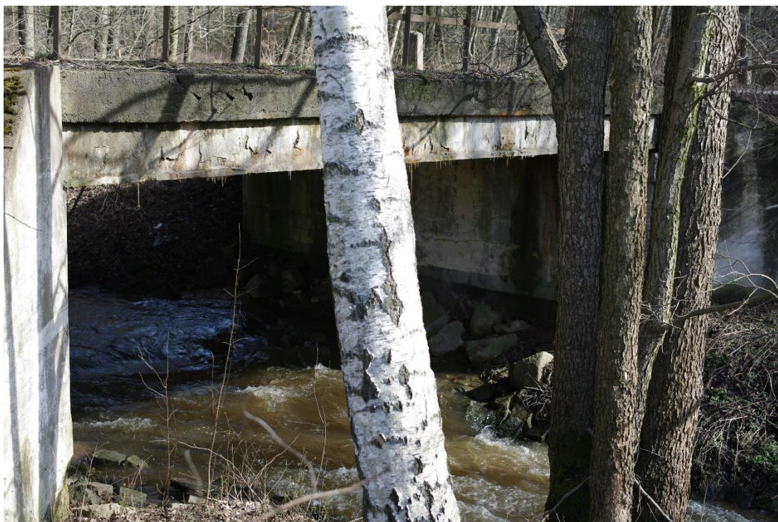
Příloha č. 5: Objekt č.10: silniční most – 3.13 ř. km
