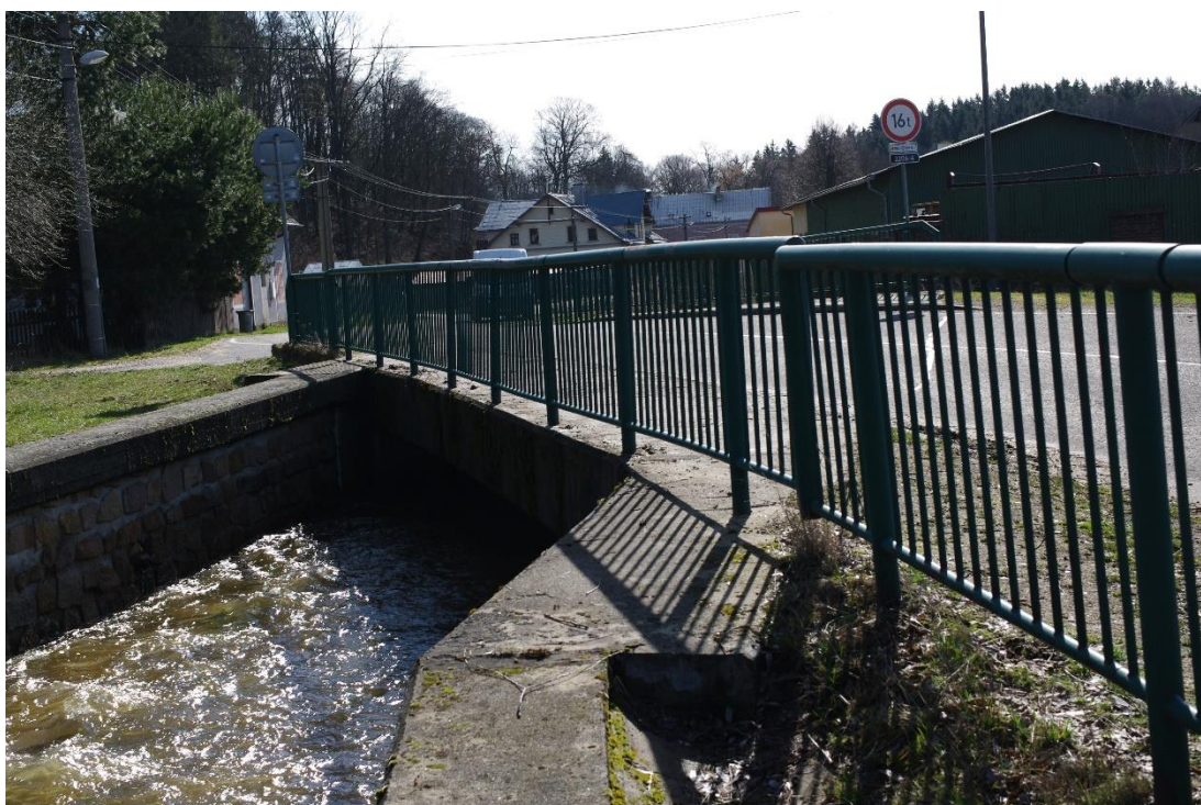
Příloha č. 9: Objekt č.19: silniční most – 10.75 ř. km
