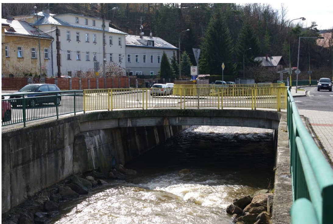
Příloha č. 2: Objekt č.3: betonový silniční most – 0.60 ř. km
