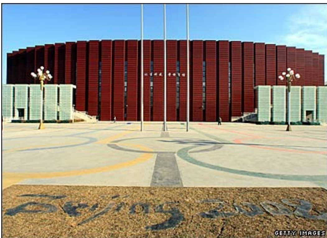
Obr. č. 10 Tělocvična Pekingské vědecko-technické univerzity
