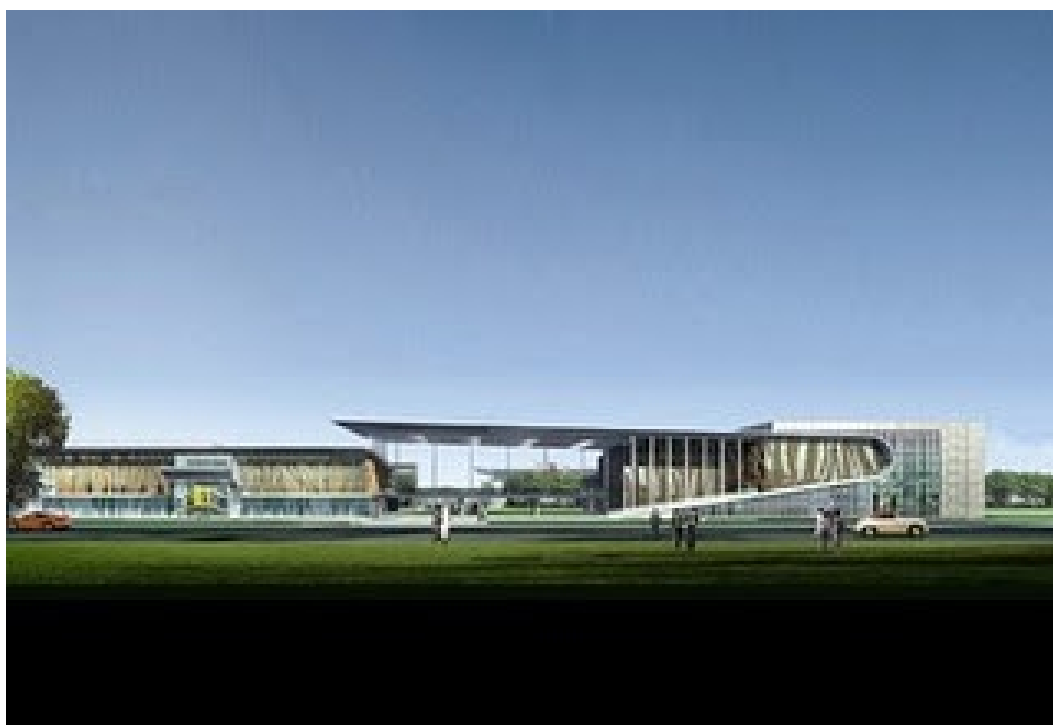
Obr. č. 14 Pekingská střelecká hala
