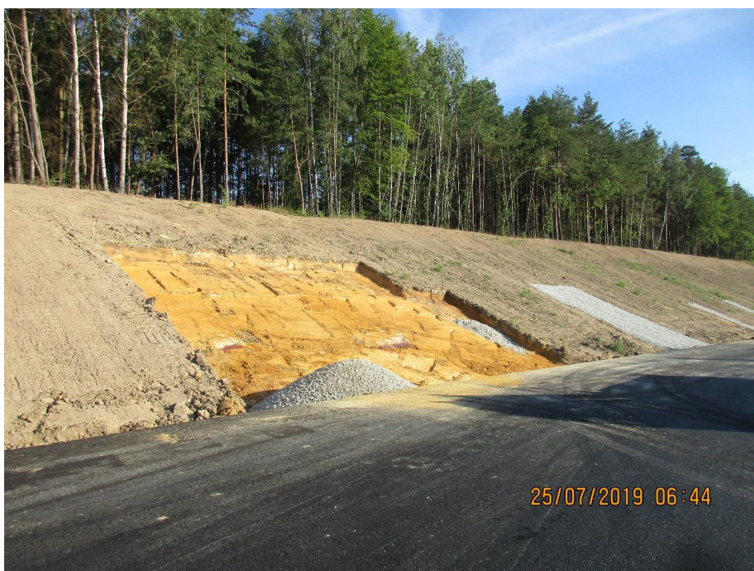
Obrázek 23: Příprava plošného svahového žebra (EUROVIA CS, 2018)
