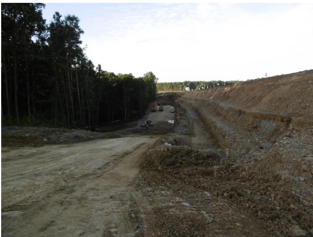
Obrázek 30: Výstavba armovaného svahu (EUROVIA CS, srpen 2018)
