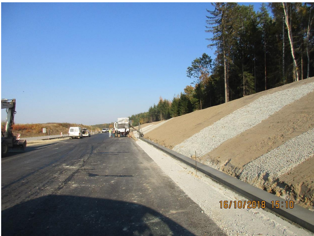
Obrázek 21: Plošná svahová žebra (EUROVIA CS, 2018)
