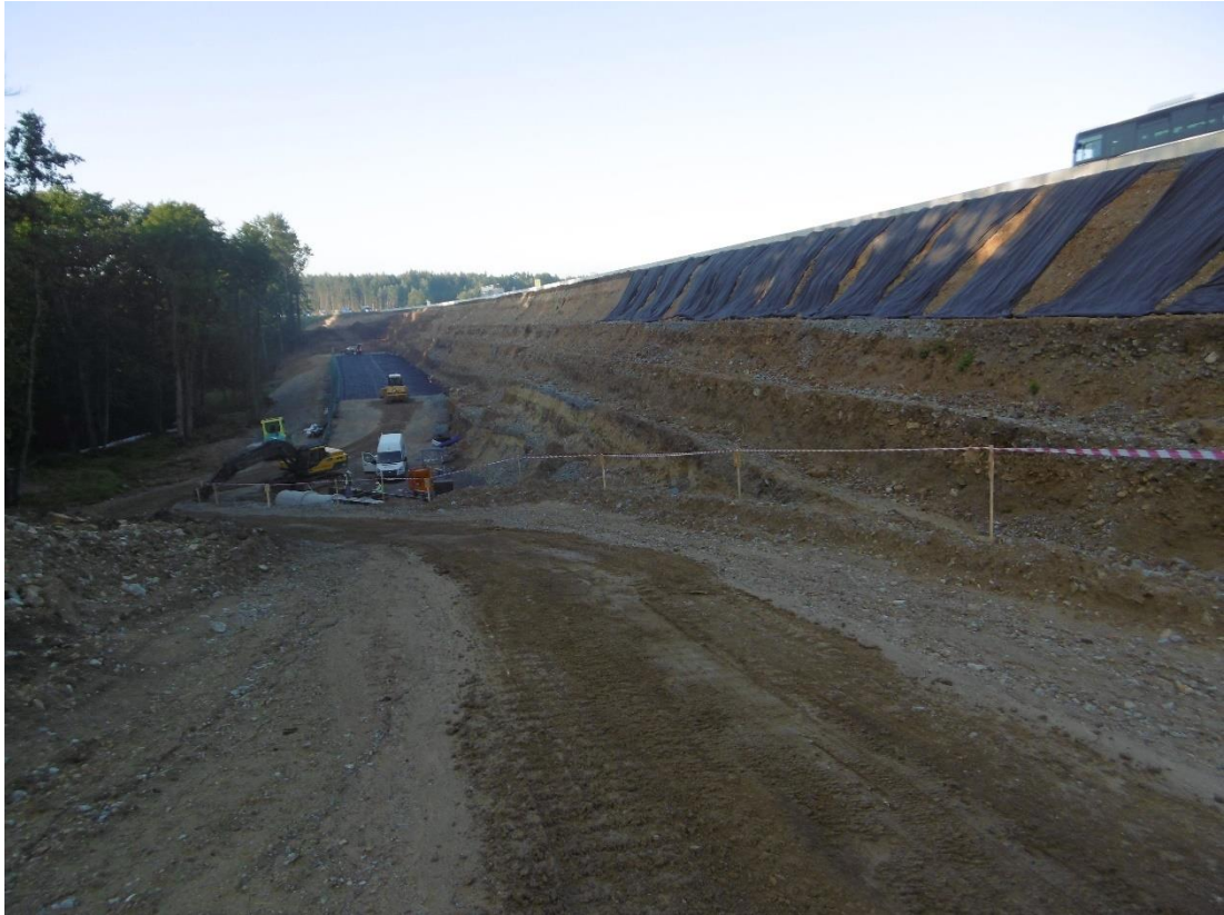
Obrázek 31: Výstavba armovaného svahu (EUROVIA CS, září 2017)
