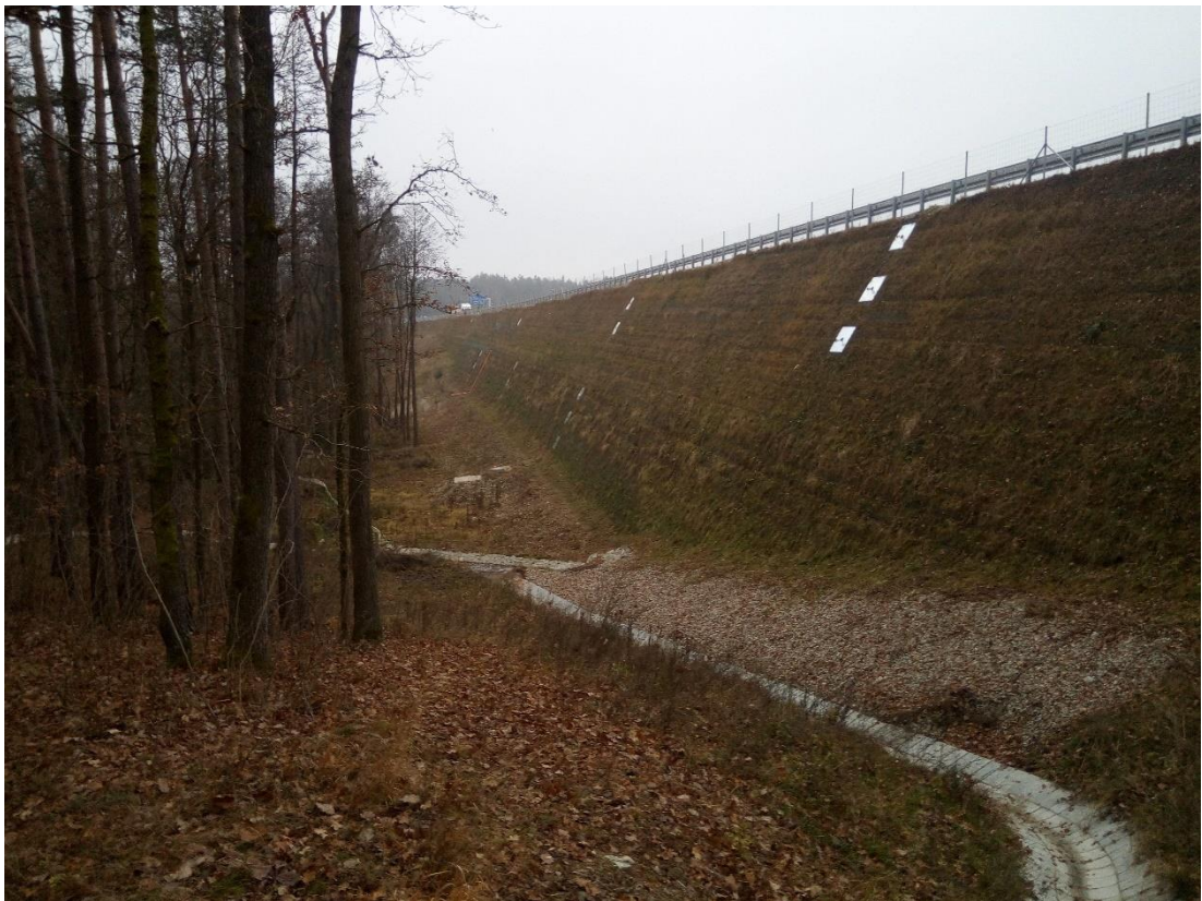
Obrázek 34: Armovaný svah (EUROVIA CS, listopad 2019)
