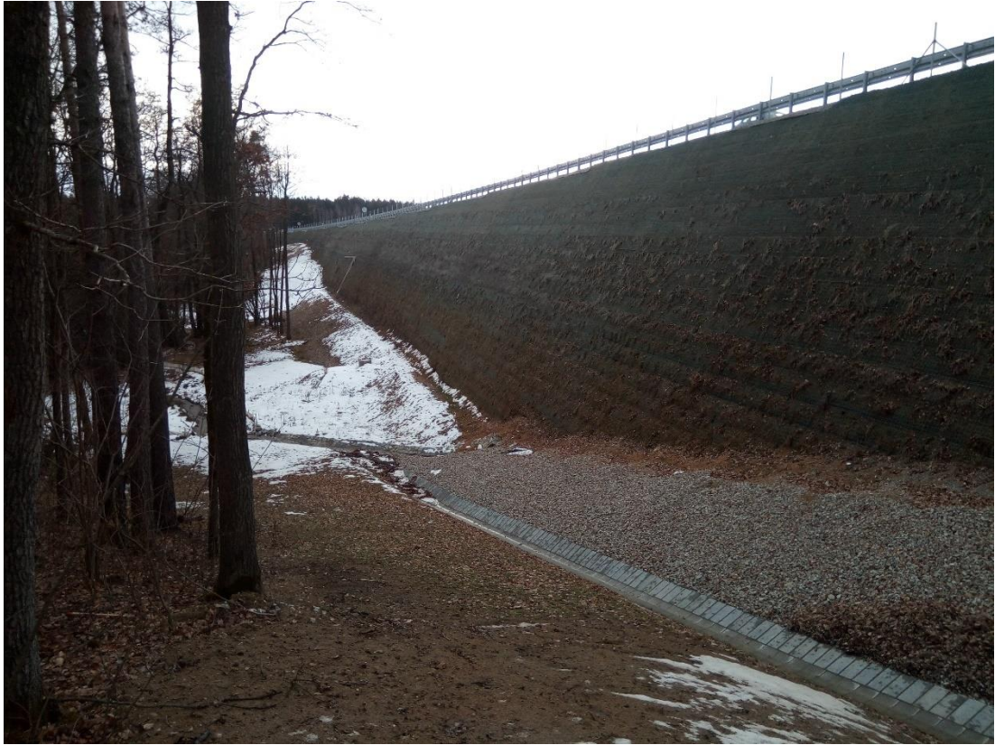
Obrázek 33: Armovaný svah (EUROVIA CS, únor 2019)
