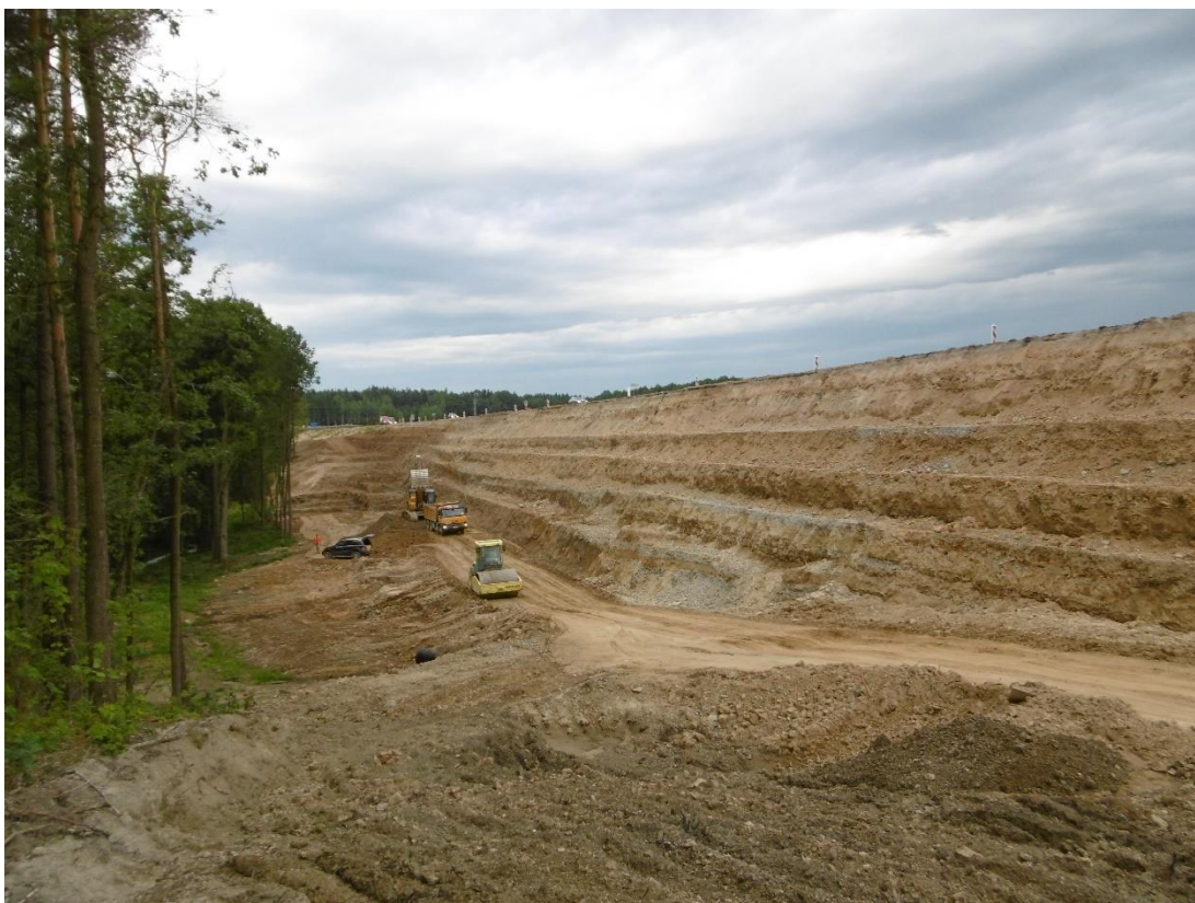
Obrázek 29: Přípravné práce na výstavbu armovaného svahu (EUROVIA CS, srpen 2017)
