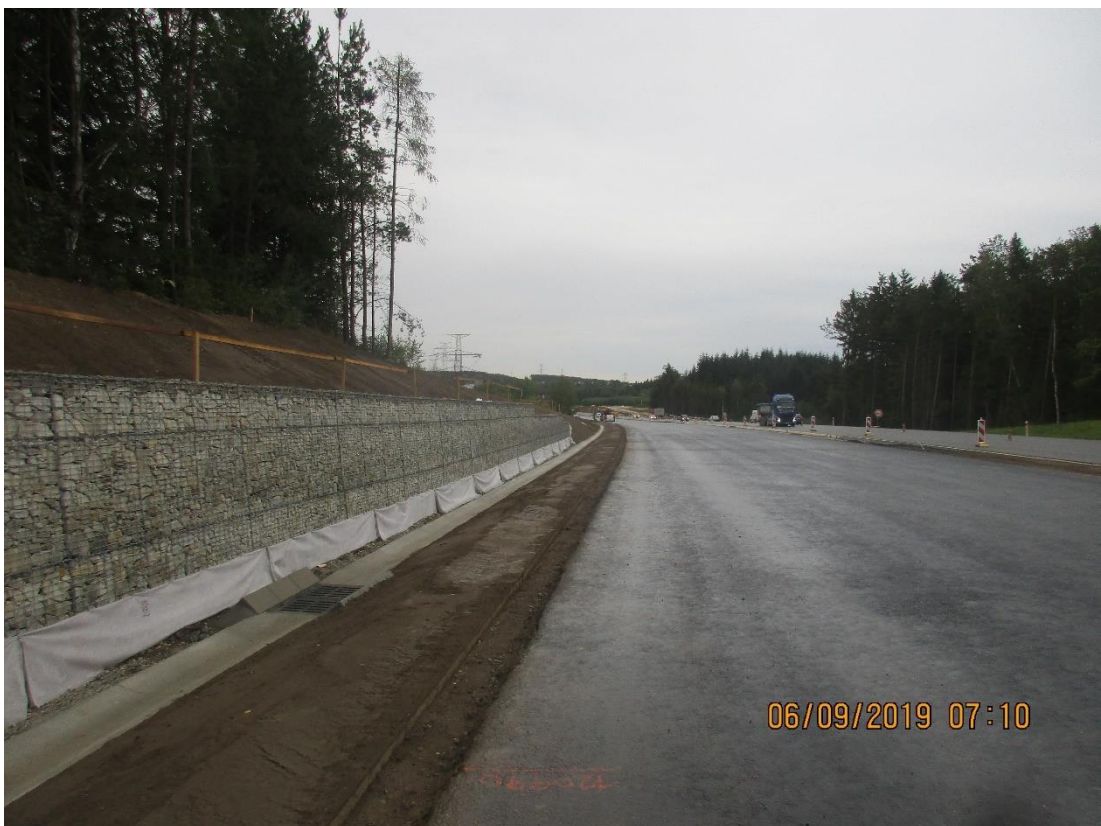
Obrázek 39: Dokončená gabionová zeď (EUROVIA CS, 2019)
