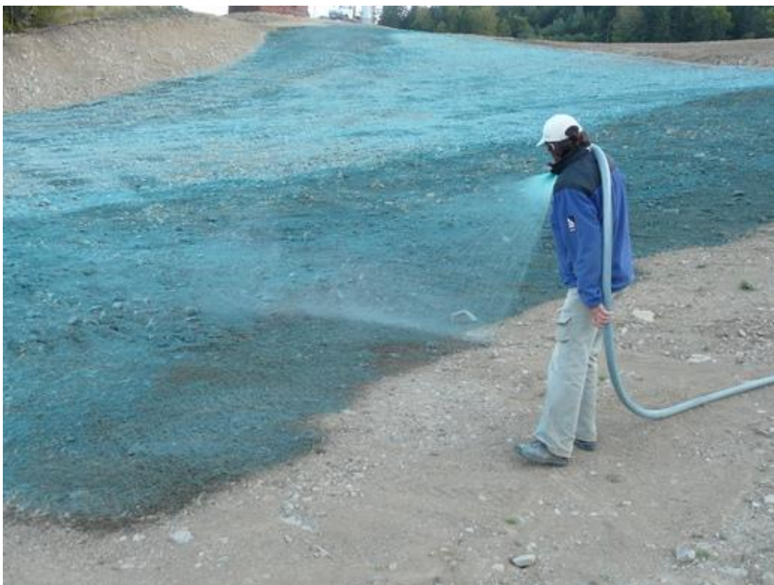
Obrázek 11: Aplikace hydroosevu (HYDROOSEV, 2021)
