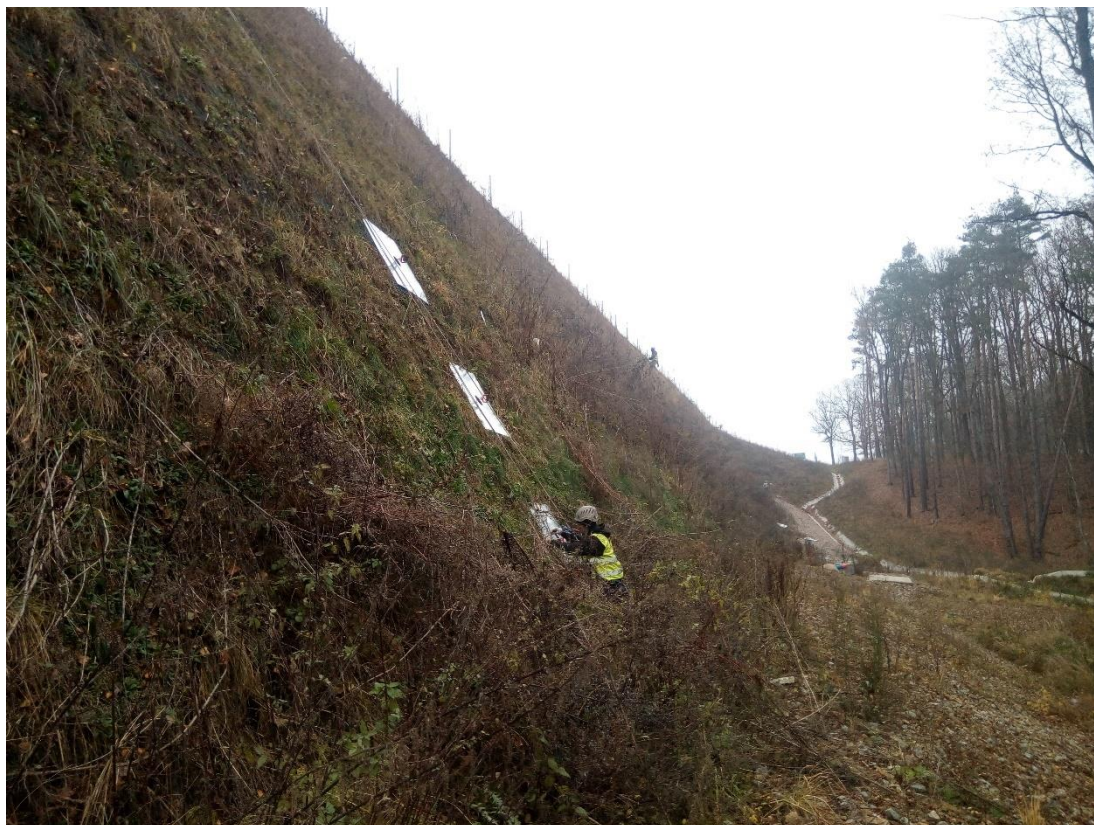
Obrázek 35: Údržba armovaného svahu (EUROVIA CS, 2019)
