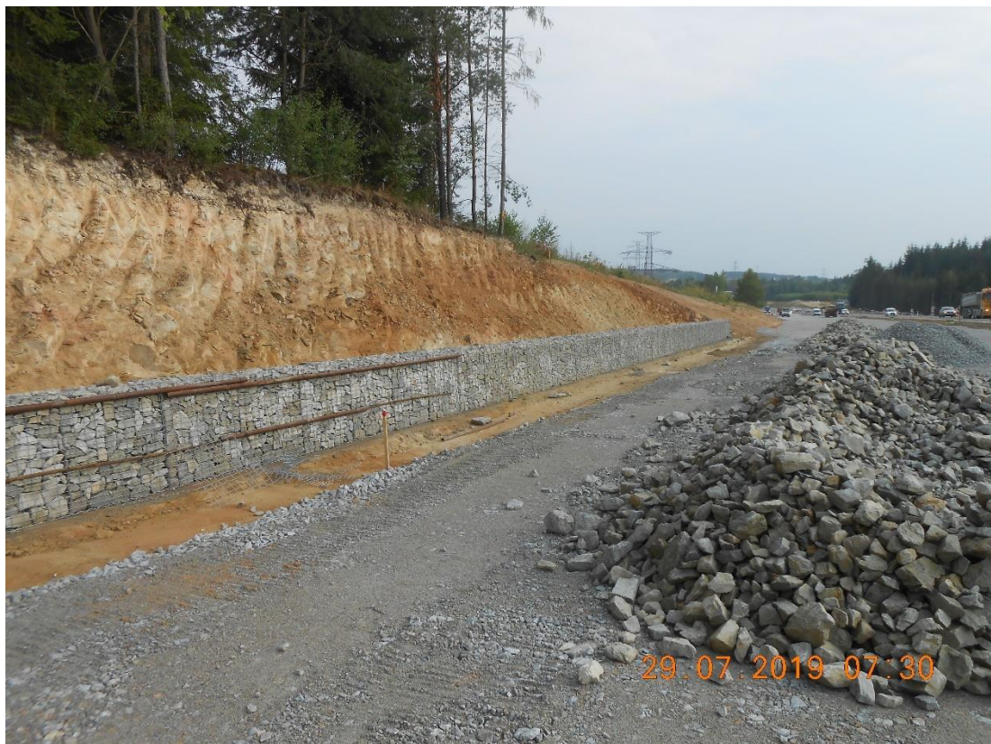
Obrázek 37: Stavba gabionové zdi (EUROVIA CS, 2019)
