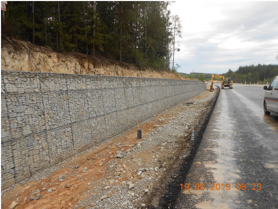
Obrázek 38: Gabionová zeď (EUROVIA CS, 2019)
