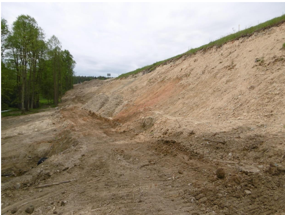
Obrázek 27: Odstranění vegetace a humózní vrstvy stávajícího svahu (EUROVIA CS, květen 2017)
