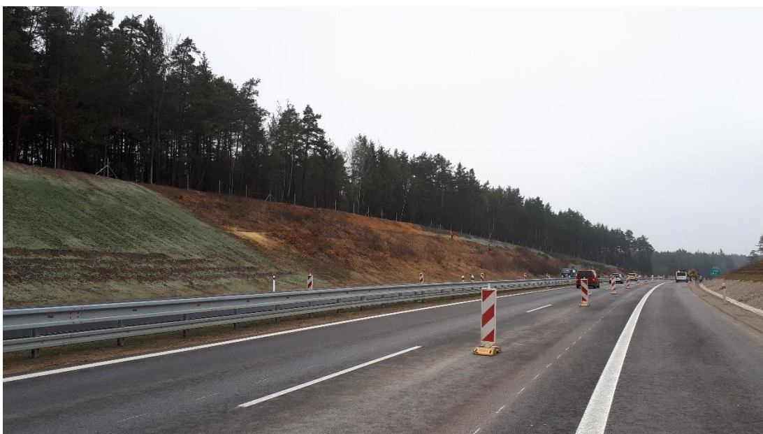
Obrázek 41: Hydroosev (EUROVIA CS, 2019)
