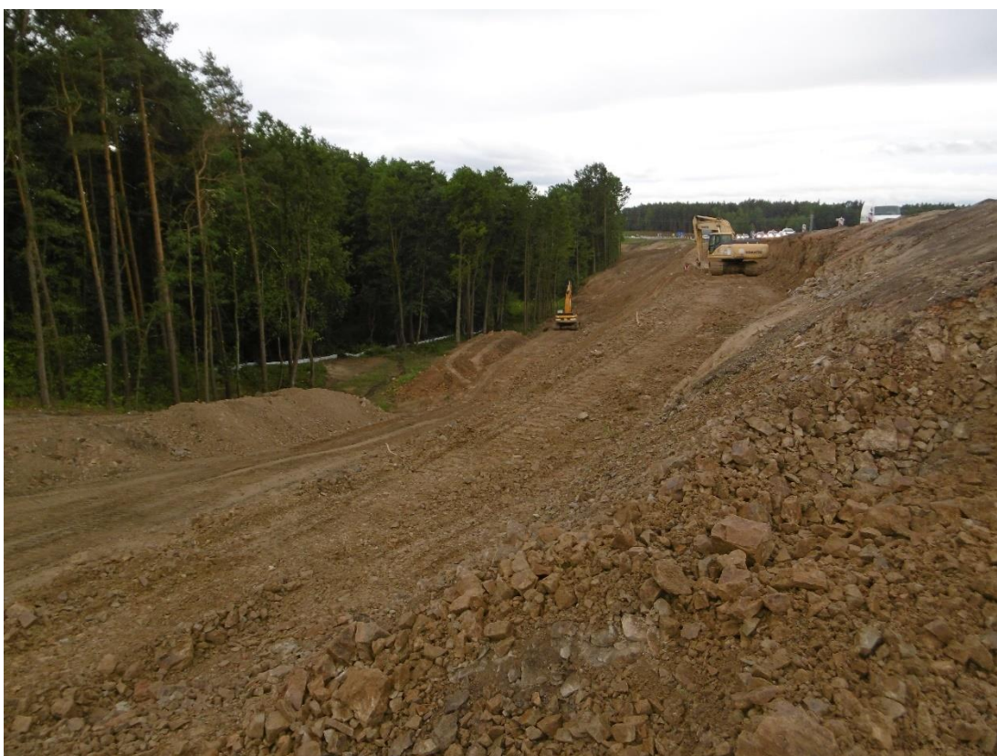
Obrázek 28: Zazubování stávajícího násypového tělesa dálnice (EUROVIA CS, červen 2017)
