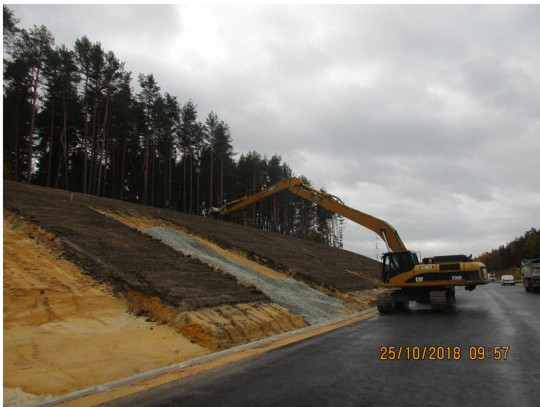
Obrázek 22: Stavba plošného svahového žebra (EUROVIA CS, 2018)
