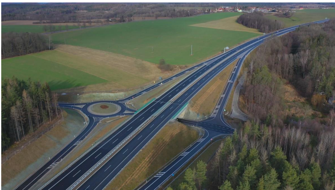
Obrázek 13: Novostavba úseku dálnice D3 Ševětín – Borek (EUROVIA CS, 2020)
