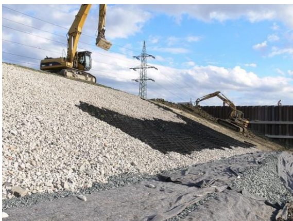
Obrázek 8: Aplikace geobuněk (GEOMALL, 2020)
