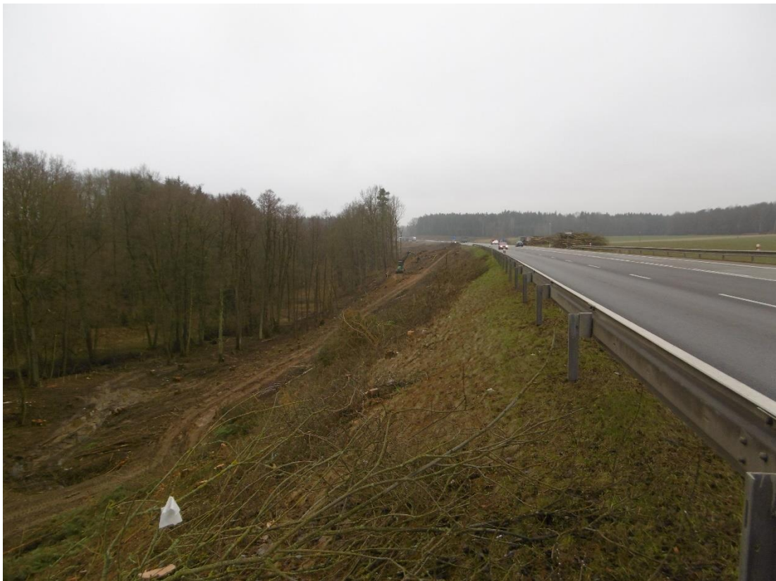
Obrázek 26: Před zahájením výstavby armovaného svahu (EUROVIA CS, březen 2017)
