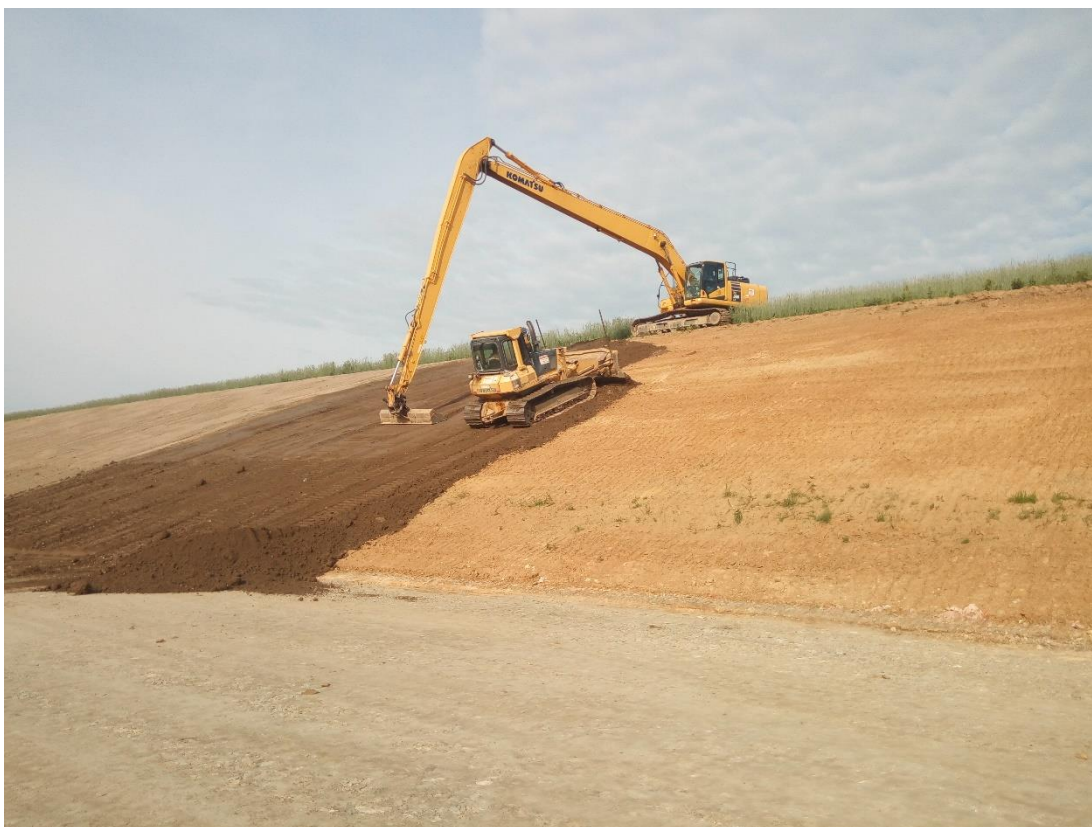
Obrázek 40: Ohumusování (EUROVIA CS, květen 2019)
