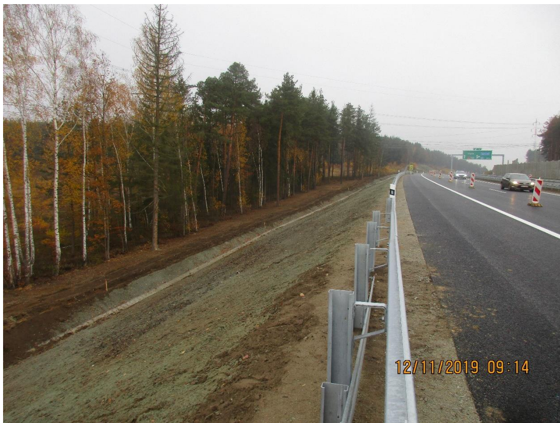
Obrázek 42: Hydroosev (EUROVIA CS, 2019)
