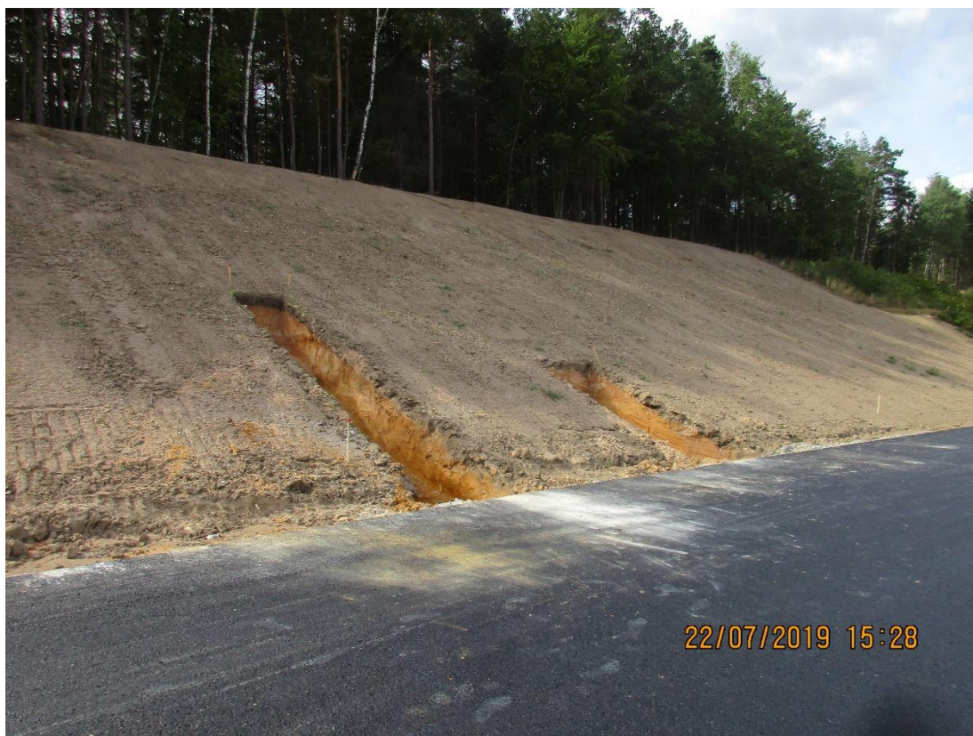
Obrázek 19: Lokální svahové žebra (EUROVIA CS, 2019)
