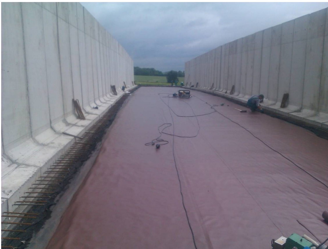
Obr. 6 Výroba betonové podlahy v silážním žlabu
