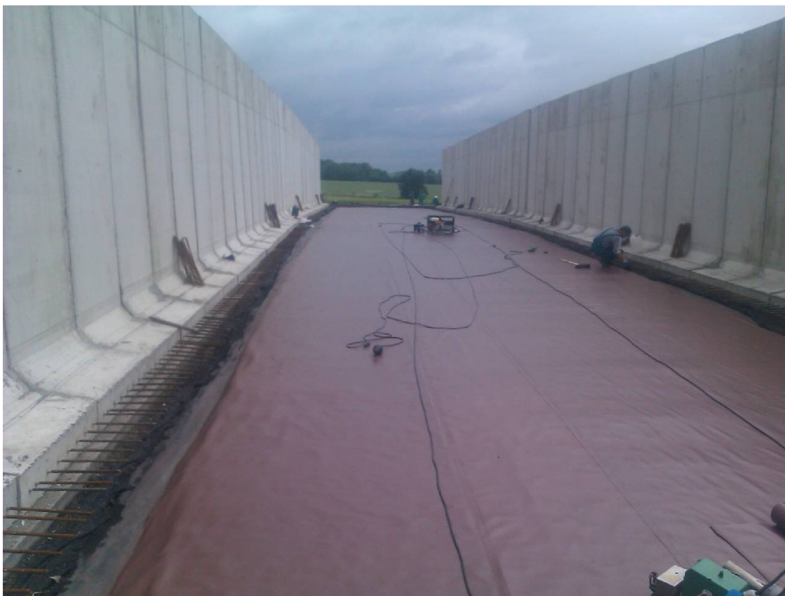
Obr. 6 Výroba betonové podlahy v silážním žlabu
