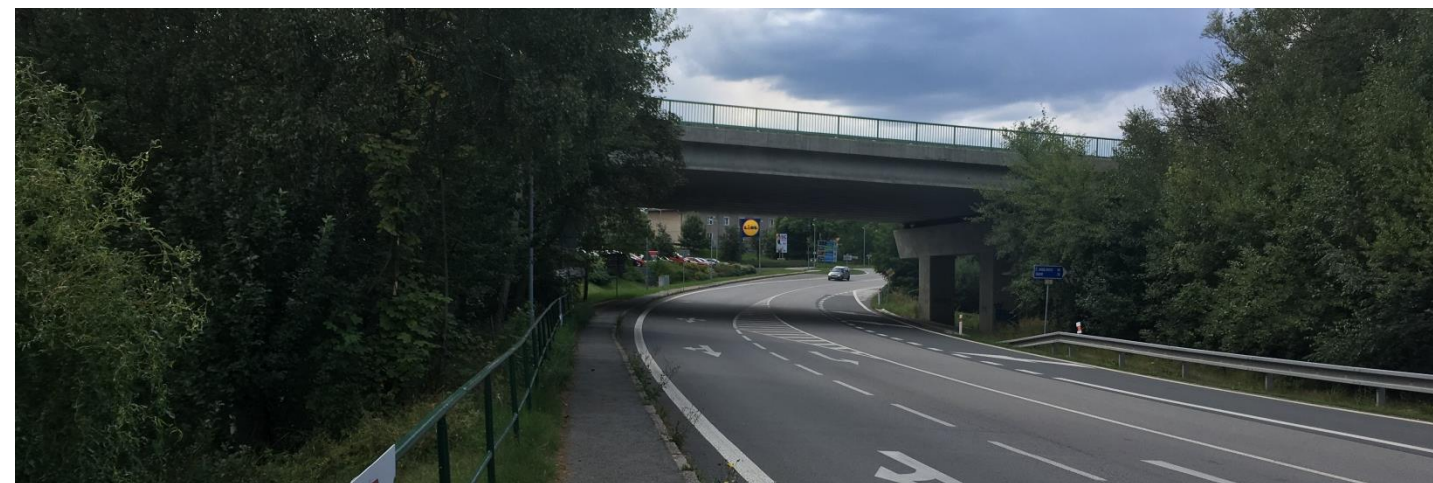
Obrázek č. 18: Podchod pod R3 u nájezdu na tuto silnici.
