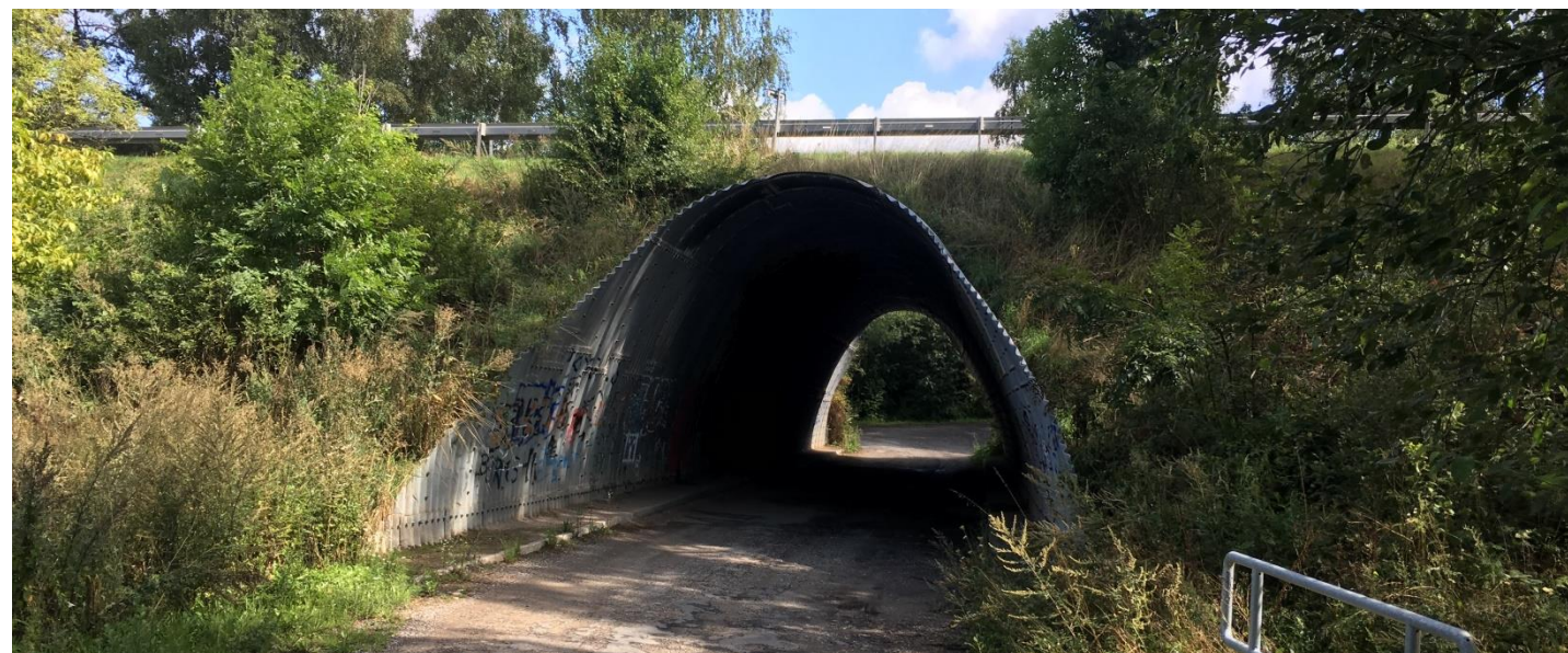
Obrázek č. 16: Podchod pod silnicí R3 v Javorské ulici.
