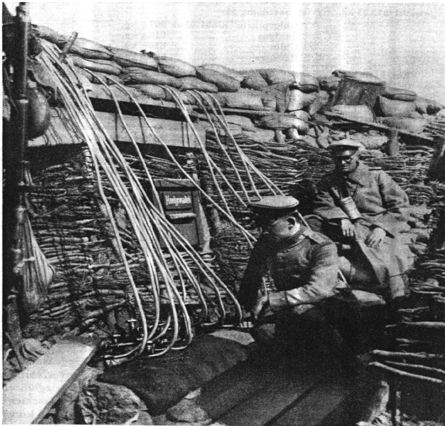
Obrázek č. 6 – Příprava tlakových lahví k vypouštění 19
