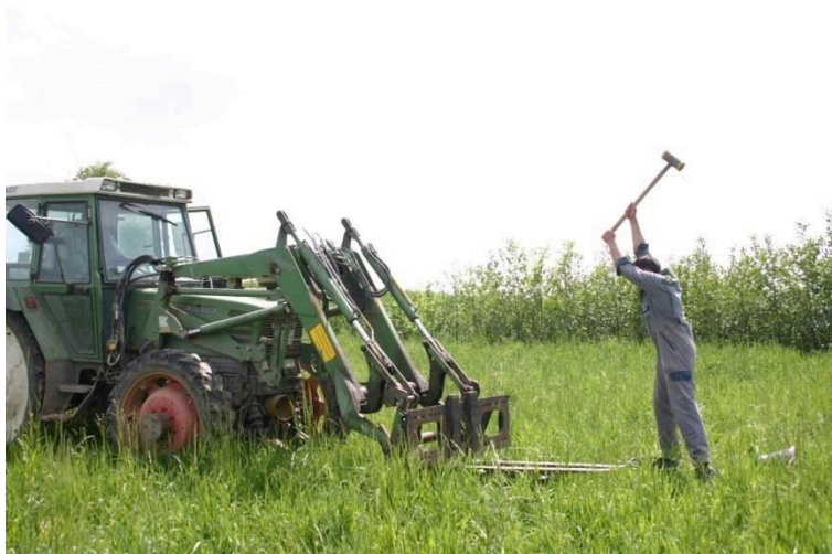
Obr. 17: Metoda monolitu - zarážení rámu do země.
