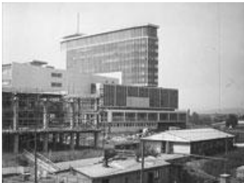
Obrázek 4: Výstavba televizního střediska – Kavčí hory - Praha
