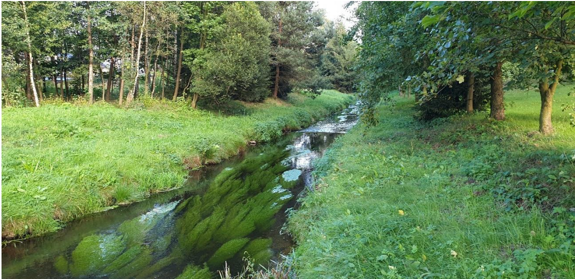
Obr. 5.6 – II. dílčí úsek (pohled po proudu)
