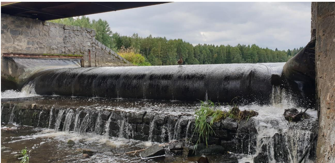
Obr. 5.23 – Bezpečnostní přeliv (pohled proti proudu)
