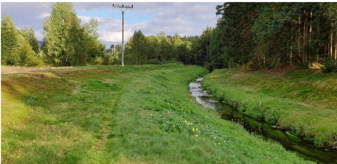
Obr. 5.7 – II. dílčí úsek (pohled po proudu)
