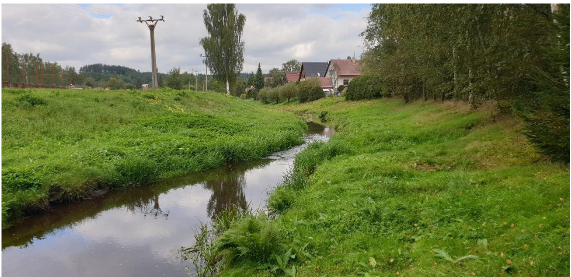
Obr. 5.9 – III. dílčí úsek (pohled po proudu)
