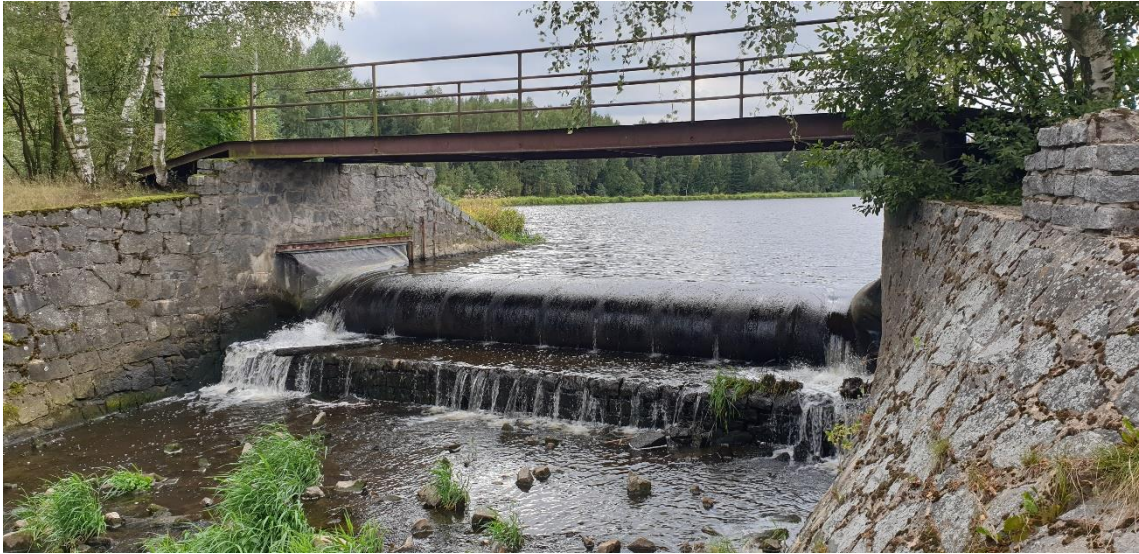
Obr. 5.10 – IV. dílčí úsek v místě vakového uzávěru (pohled proti proudu)
