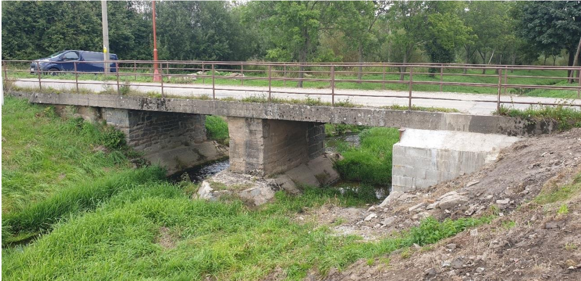
Obr. 5.22 – Silniční betonový most M2 (pohled po proudu)
