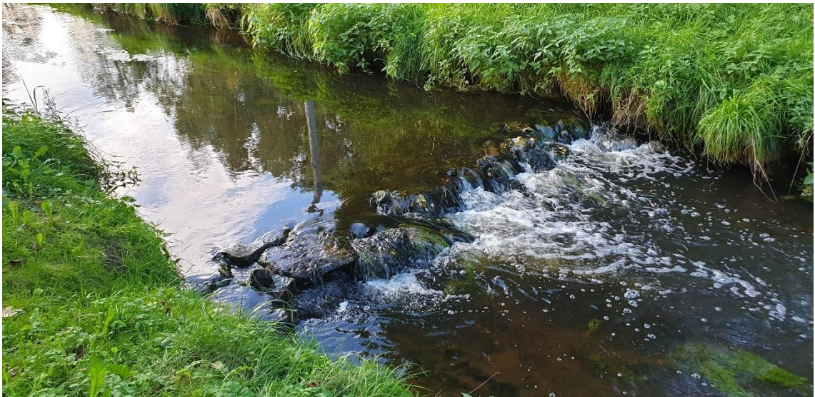
Obr. 5.15 – Kamenný stupeň ve dně (pohled proti proudu)
