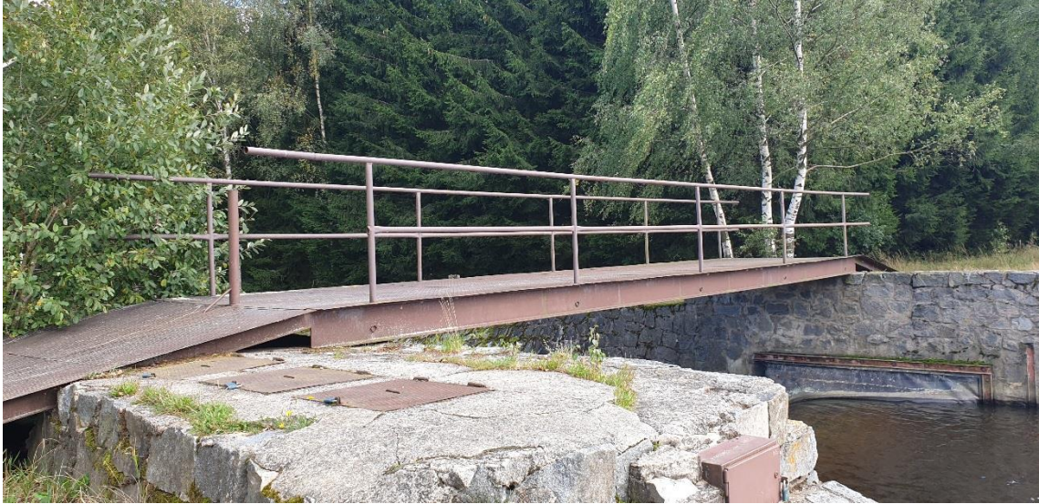
Obr. 5.24 – Ocelová lávka L4 (pohled po proudu)
