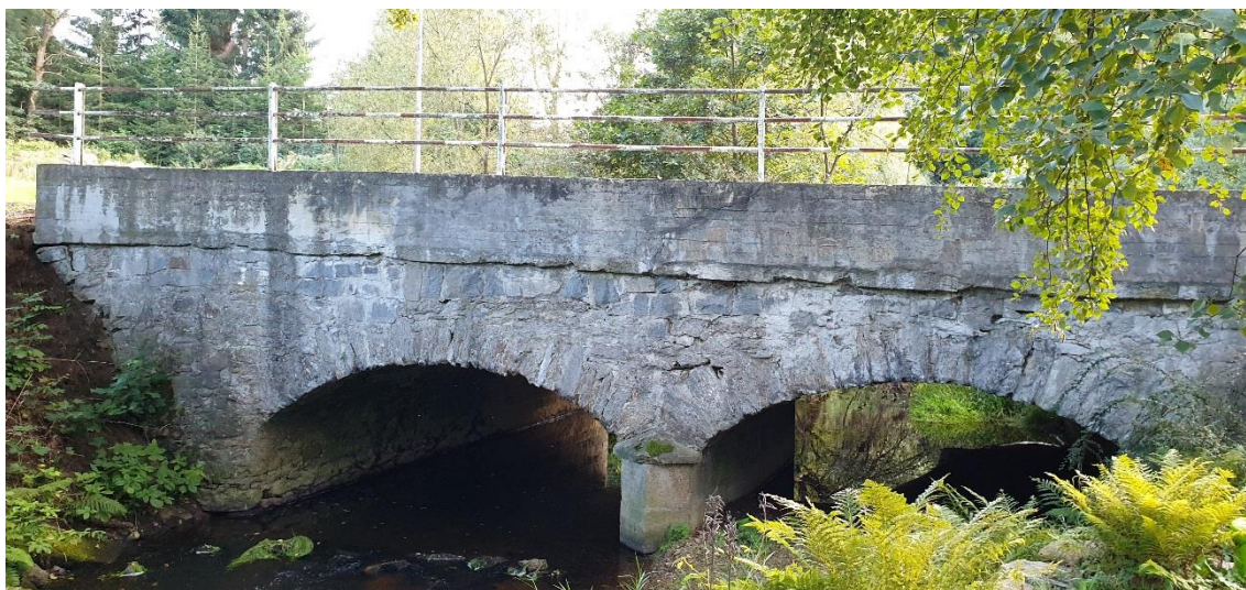
Obr. 5.13 – Silniční kamenný most M1 (pohled proti proudu)
